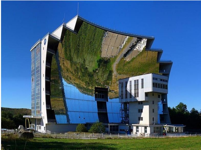
*Figure 8: Four solaire d'Odeillo dans les Pyrénées-Orientales permettant d'atteindre des températures supérieures à 3500 °C.*
