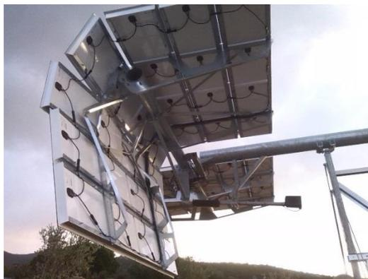
Figure III. 38: Dégâts sur l'installation CPV à Ajaccio suite à une tempête de vent
