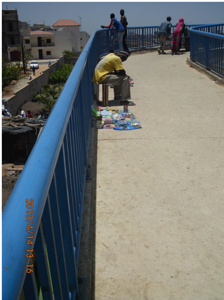
Figure 100 : des vendeurs envahissant les passerelles piétonnes. (Sources A. Kantoussan)
