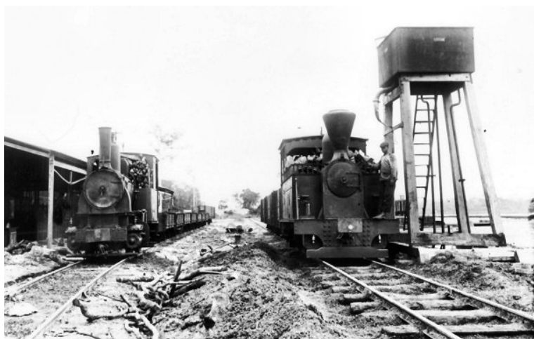
Figure 10 : Point de ravitaillement sur une ligne ferroviaire (Sources : Base de données Ulysse)
