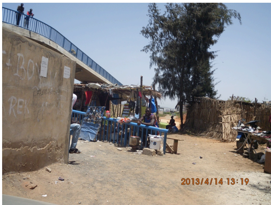
Figure 101 : des vendeurs envahissant les passerelles piétonnes. (Sources A. Kantoussan)
