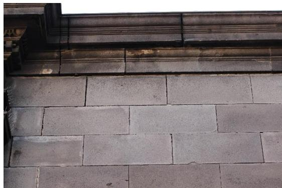
PM4 : Absence de joint en élévation du fait de la présence d'infiltrations au niveau de la toiture
