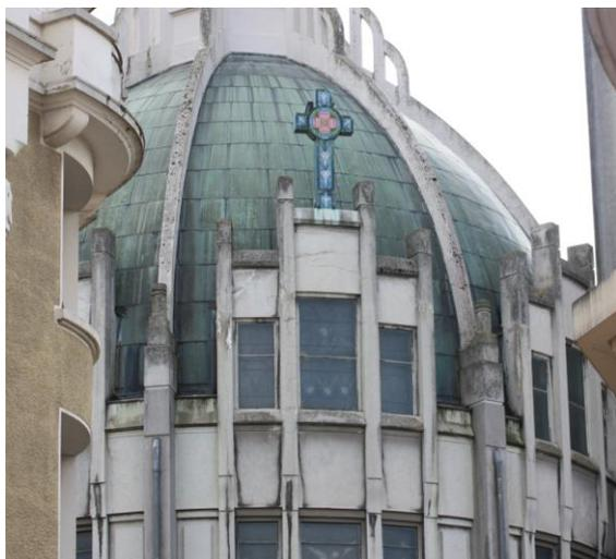
AA1 : Traces sombre sur la coupole dans la coupole et DEP. Vérification de l'état des DEP située autour de la coupole afin de vérifier leur bon état et qu'elle n'engendre pas d'infiltrations à l'intérieur de la coupole
