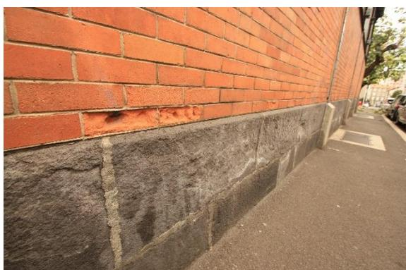
AC4 : Cristallisation de sels sur une pierre de Volvic Creusement de briques entre la jonction avec la pierre de volvic
