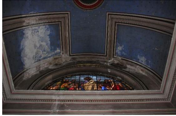
F1 et D6 : fissuration importante et présence d'humidité au niveau de la voute (zone raccord de la toiture en zinguerie)
