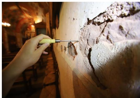
PM4 : Dégradation du à l'humidité du mur qui ne peut pas s'évacuer en soubassement dans elle migre par remontée capillaire et détériore l'enduit. Cette humidité est peut-être accompagnée de sels.
