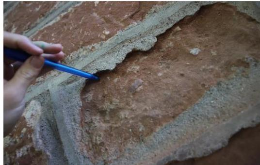
PM1 : Altération des pierres en façades car utilisation d'un mortier hydraulique
