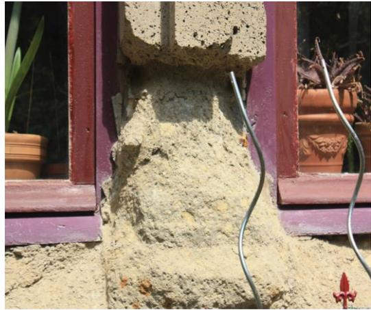
PM3 : Perte d'intégrité des pierres d'encadrement de fenêtre → Remplacement pierre
