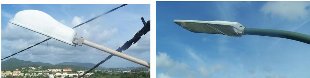
*Photo 6 : Vieux luminaire (gauche) et nouveau luminaire LED (droite).*
