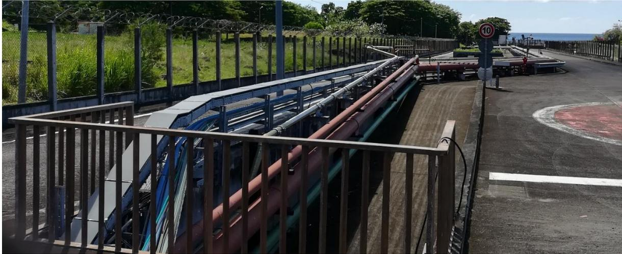
*Photo 4 : Interface mer-centrale à Bellefontaine permettant l'approvisionnement pétrolier.
