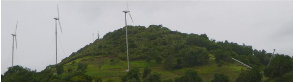
*Photo 12 : Les quatre éoliennes du Vauclin. Elles sont couchables, comme celle de droite, afin de les protéger des cyclones ou pour faciliter les opérations de maintenance.*
