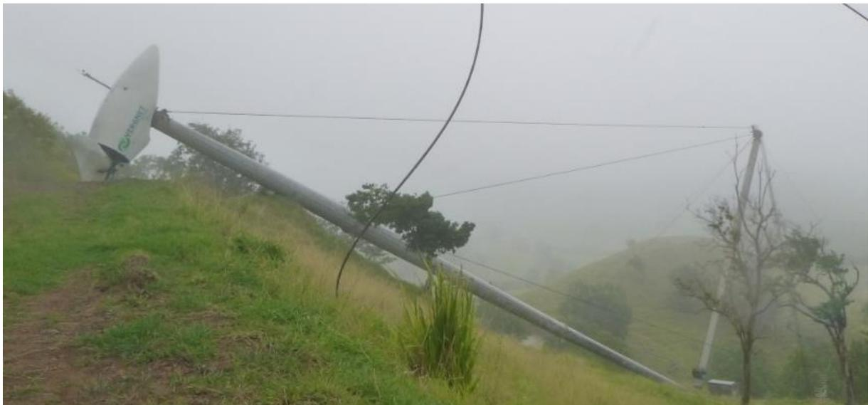
*Photo 25 : Les éoliennes du Vauclin couchées pour maintenance.*
