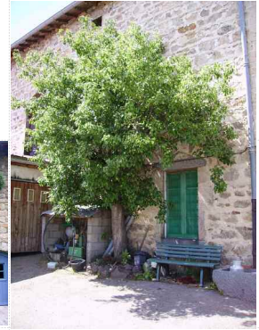
Ici on coupe « ce qui gêne » : autour de la fenêtre, sous l'appentî...
