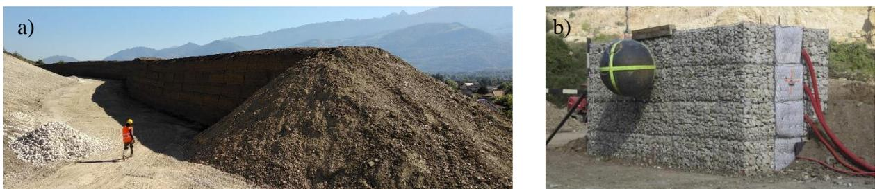
Figure 1.4 : a) Merlon en remblai de terre avec parement amont en gabion remplis de pierres (A. Furet) b) Structure sandwich testée sous impact (Heymann, 2012)
