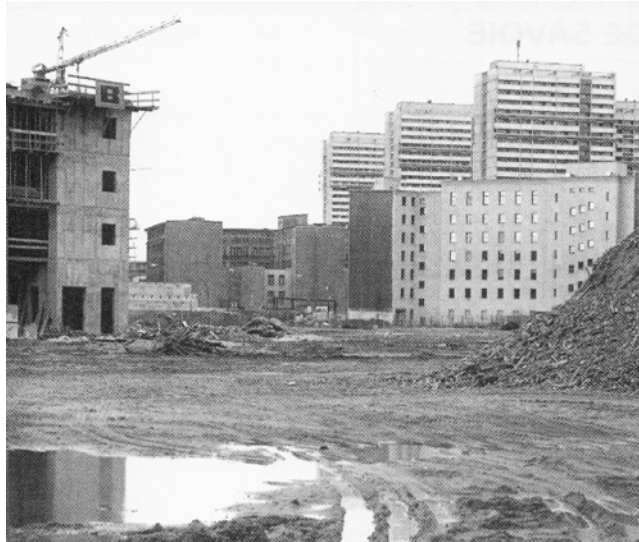
Photo de la plaquette : immeuble en construction
