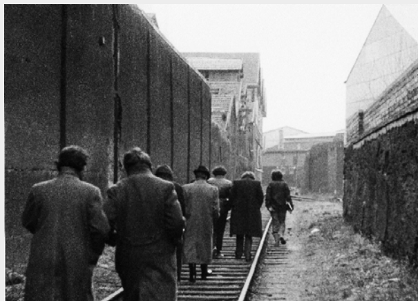
Le long des rails (photo de repérage)
