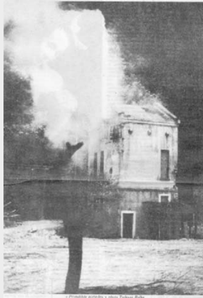
Bâtiment en feu
