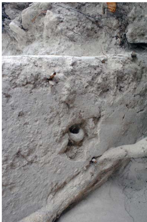
Figure 6.24 : paroi ouest de la banquette de la Pièce 3 de l'Edifice 6O-8, avec une pierre percée intégrée au centre de la maçonnerie servant d'accroche pour tentures (Sion 2011)
