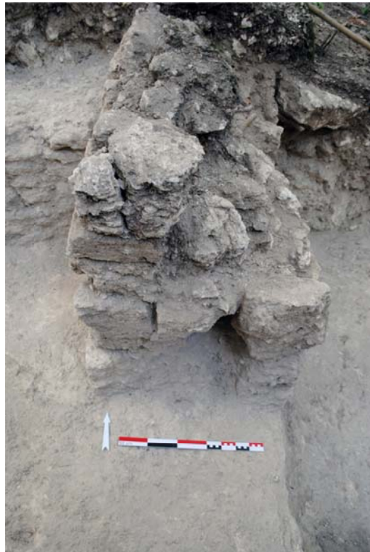
Figure 7.45 : jambage nord de la porte de la Pièce 1 de l'Edifice 6O-48, avec la niche (détériorée) devant permettre la fermeture de cet accès (Sion 2014)
