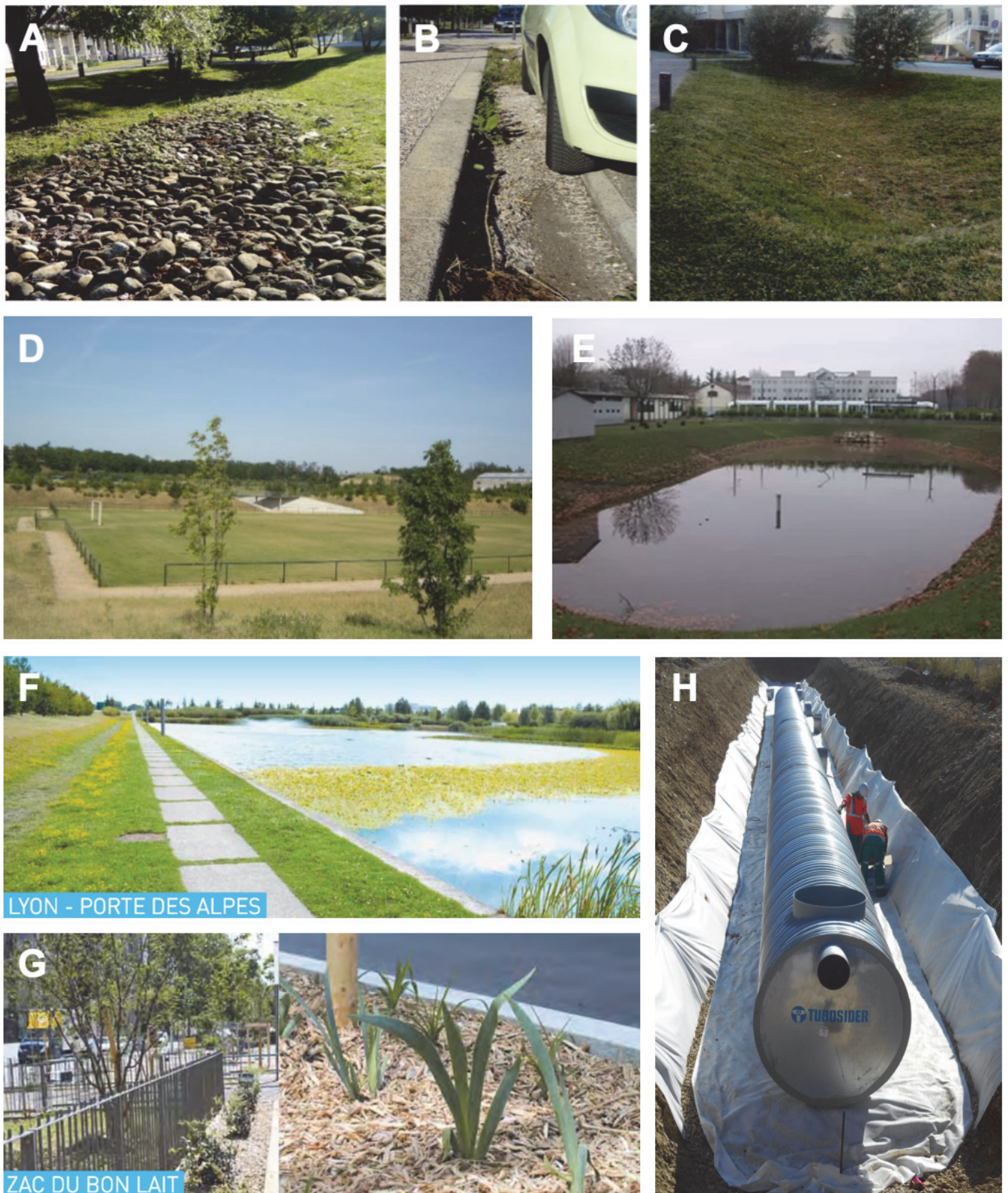
Figure 2.2. Aménagements urbains permettant l'infiltration des eaux pluviales. A) rivière sèche, B) tranchée drainante, C) noue végétalisées, D) terrain de football, E) bassin d'infiltration, F) lac artificiel, G) bande végétalisée et H) buse drainante.
