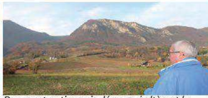
Des constructions «isolées» qui altèrent la coupure verte
