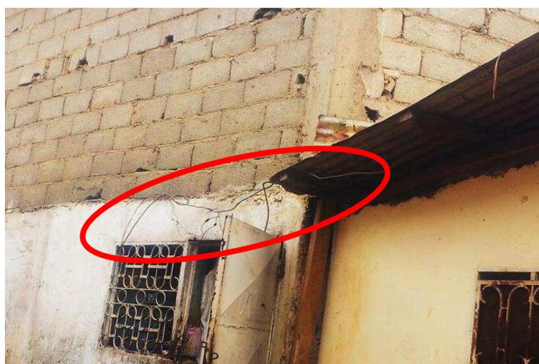
**Photo 25 : Vue des câbles de distribution illégale de l'électricité à la Briqueterie**
