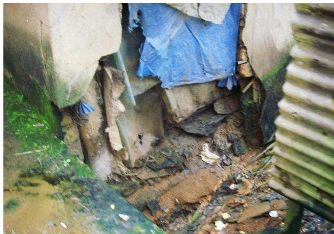
**Photo 15 : Vue d'une partie du mur d'une habitation complètement ouverte sous l'effet de l'humidité corrosive à Melen**
