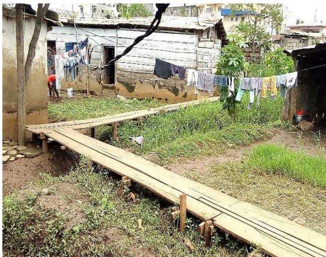
**Photo 88 (a&b) : Vue du pont d'accès aux maisons d'habitation construit en planches de bois à Elig-Edzoa**
