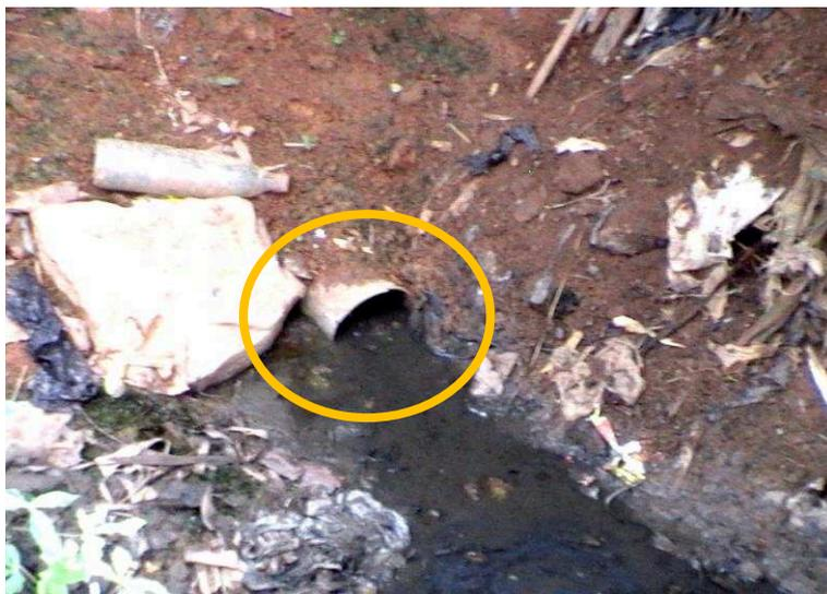
**Photo 50 : Vue d'un "canon" camouflé d'évacuation des excréta vers une rivière à Nlongkak**
