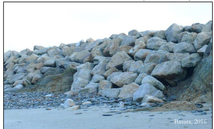
Enrochement de l'ensemble de la falaise (Pouldreuzic, 29)
