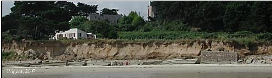
Fig. 117 : Démantèlement du mur de soutènement à Pors-Hir en 2007.
