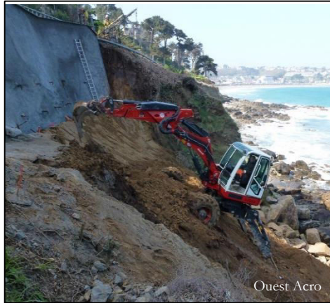
Travaux de béton projeté à Perros-Guirec (22)
