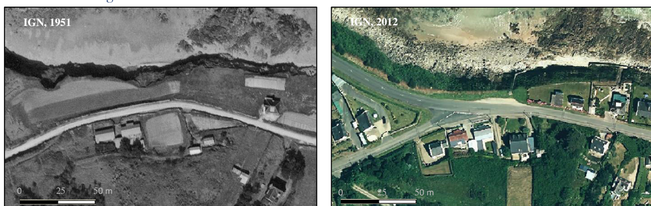
Fig. 127 : Urbanisation du sommet de falaise du Moulin de la Rive entre 1951 et 2012.
