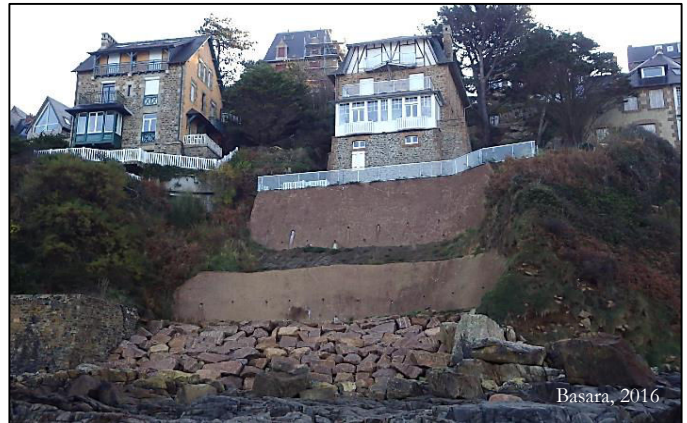
Falaise confortée par du béton projeté, un gradin, un mur et un enrochement en pied (Perros-Guirec)
