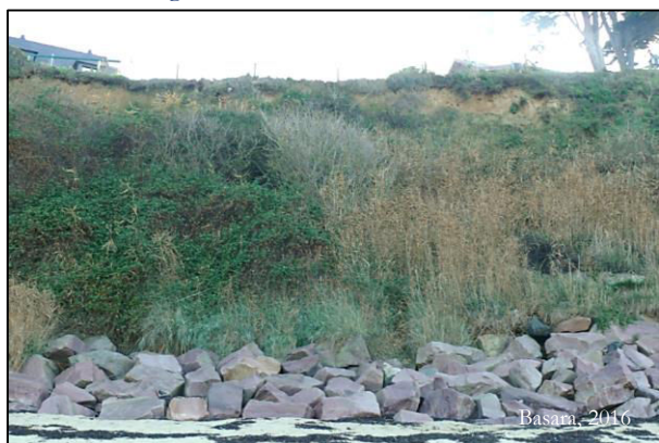
Enrochement en pied et drainage du versant (Planguenoual, 22)
