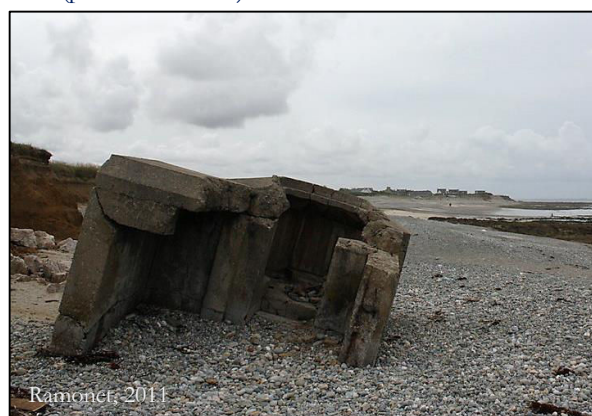
Fig. 9 : Blockhaus présent en sommet de falaise à Pléneuf-Val-André (photo de gauche) et basculé en avant des falaises meubles à Pouldreuzic (photo de droite).
