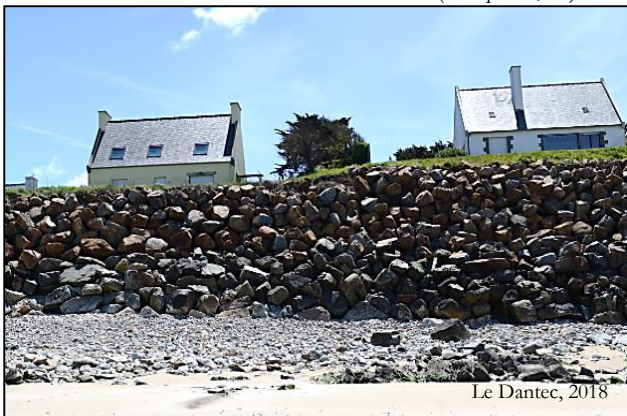
Enrochement de l'ensemble de la falaise (Locquirec, 29)
