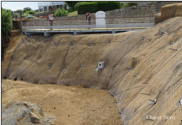
Falaise confortée par des clous et un grillage renforcé (Saint-Quay-Portrieux)
