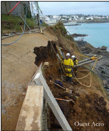
Ancrage de la paroi par des pieux à Saint-Quay-Portrieux (22)
