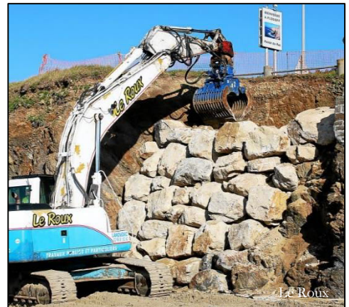
Travaux d'encrochement à Plogoff (29)
