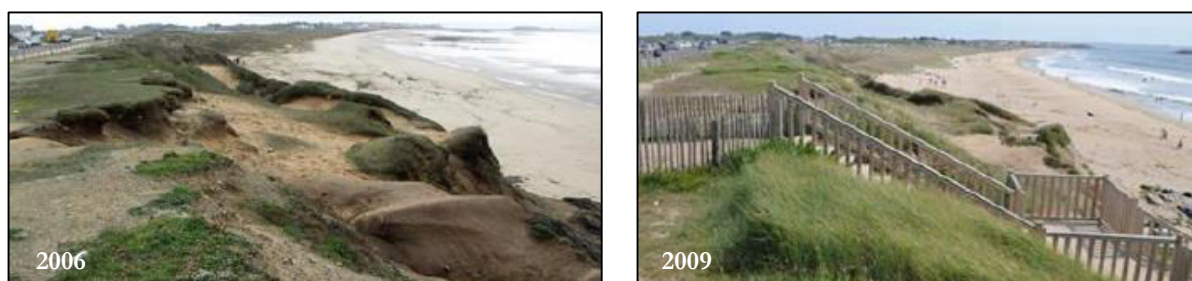
Fig. 274 : Restauration du couvert végétal et gestion de la fréquentation en sommet de falaise meuble à Lorient (Le Cornec, 2015).
