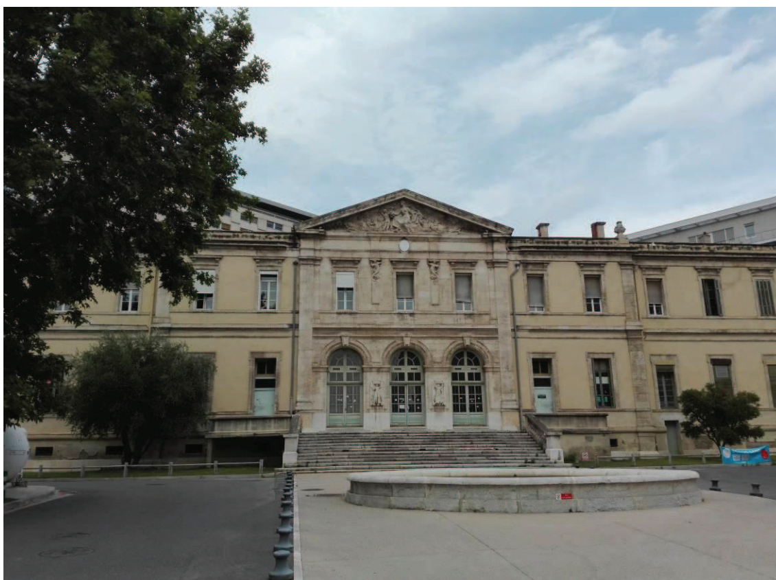
Figure 23 : Ancien bâtiment administratif du Centre d'hygiène mentale aujourd'hui 3
