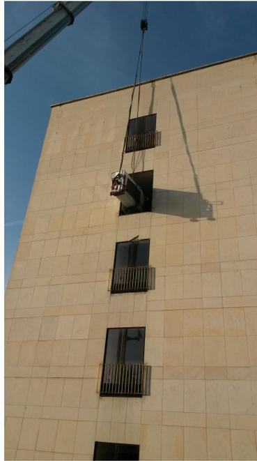
FIGURE 3.6: Arrivée de la table Newport, à l'aide d'une grue, au 3<sup>ème</sup> étage du laboratoire Interdisciplinaire de Bourgoigne. La table a ensuite été installée dans la salle où s'est déroulée l'ensemble des expériences de la thèse.
