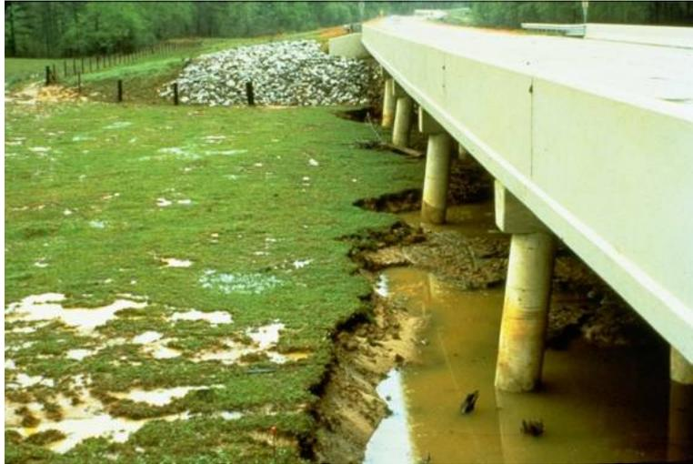
FIGURE 1 – Exemple d’affouillement : suite à une crue, le sol a été fortement érodé au pied des piles du pont. Source : <https://water.usgs.gov/osw/techniques/bs/BSDMS>.
