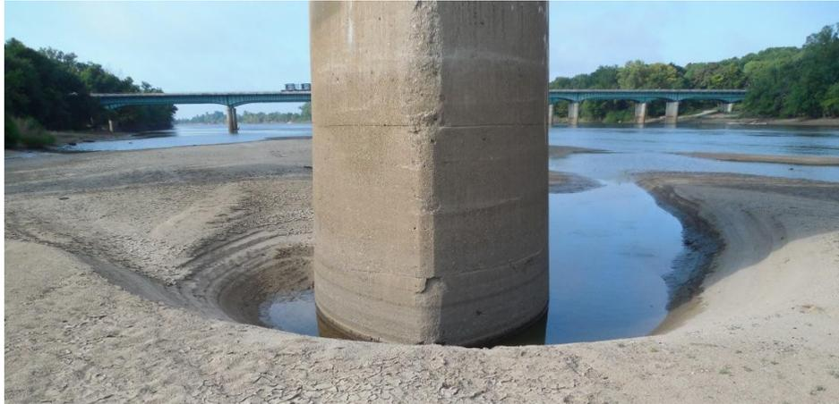
FIGURE 1.12 – Fosse d'affouillement au pied d'une pile de pont. Source : <https://www.usgs.gov/media/images/scour-hole-around-bridge-pier>.
