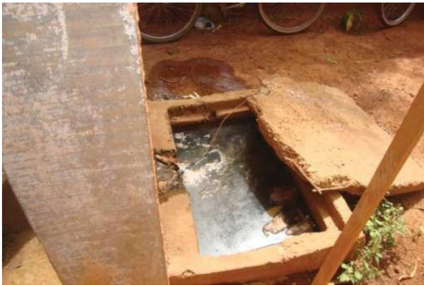
**Figure 1. 11 :** Eaux usées de la mosquée de l'université déversées dans un canal mal étanchéifié.
