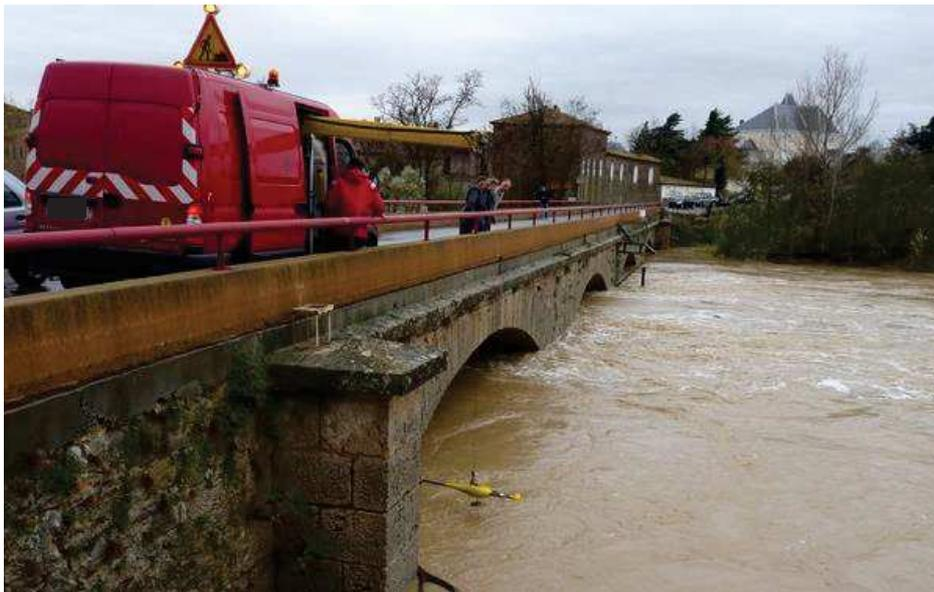
**Figure 3-5: Jaugeage au saumon (instrument jaune déposé dans l'eau par le bras de poulie rattaché au camion) au niveau du pont de Luc-sur-Orbieu lors de la crue de novembre 2014 (Source: SMMAR).**
