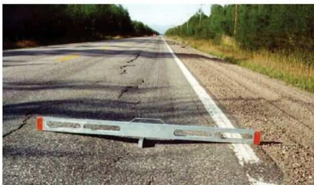
(a) Des ornières se forment et la surface s'affaisse dans les bandes de roulement avec des fissures longitudinales
