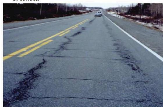
(b) La fissuration s'accroît et d'autres fissures apparaissent en surface
