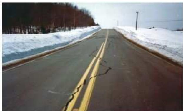
(c) Fissure longitudinale au niveau de l'axe central de la chaussée
