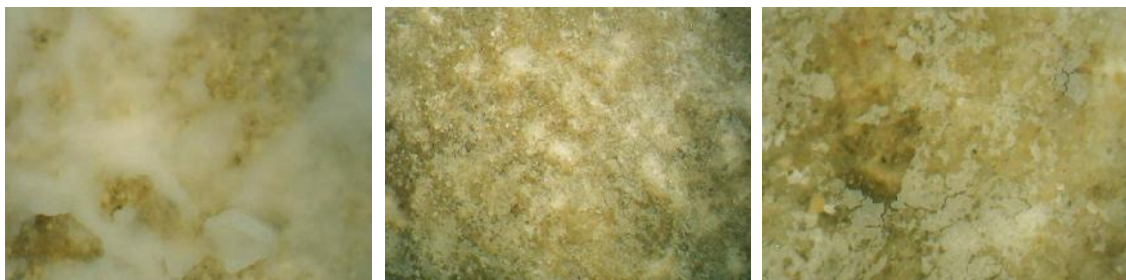
Fig. 93: État de surface grès quartzitique à T3 (X30) (vignette de gauche), à T3 après nettoyage de la couche pâteuse à l'eau (X10 vignette centrale et X30 image de droite).
