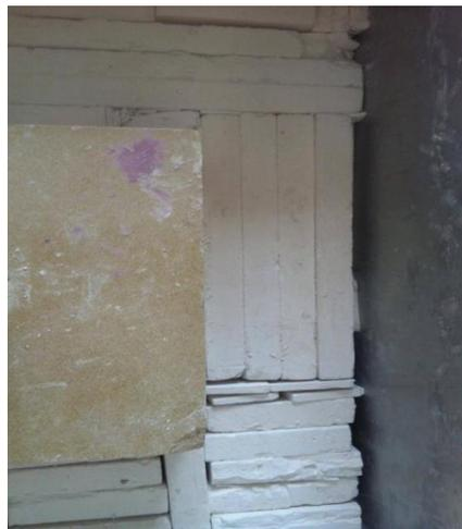
Figure 103 Panneaux isolants, autour de la veine d'air. L'assemblage en quinconce permet d'augmenter les performances de l'isolation (création de résistances thermiques aux interfaces) et de limiter les ponts thermiques et les courants de fuite d'air.
