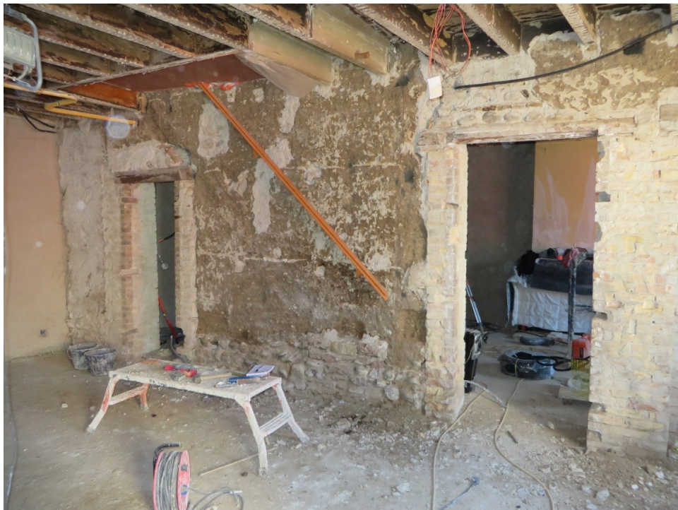
Figure 33. Mur en pisé débarrassé de son enduit évoqué par Xavier. Une partie du mur, en pisé présente de nombreux trous qu'il va falloir reboucher avant de faire les enduits. Le décroustage du mur a aussi permis de faire apparaître une porte supplémentaire (à gauche), ainsi qu'une fuite d'eau, un peu plus haut, qu'il a fallu réparer.
