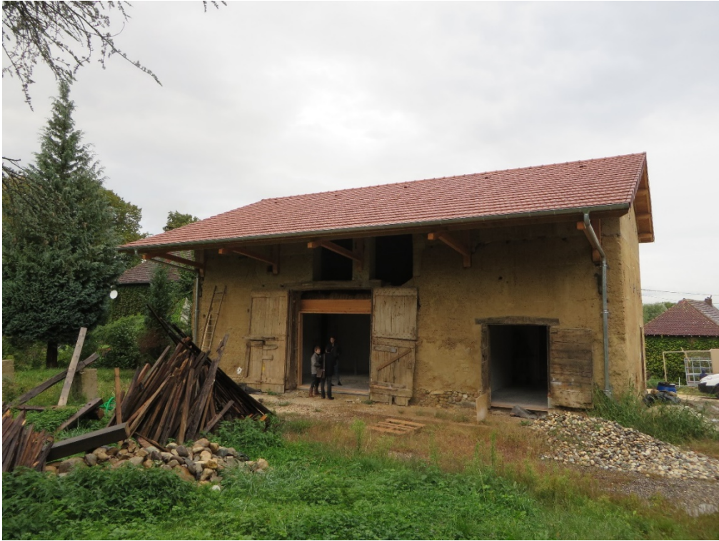
Figure 57. Grange transformée en habitation à Pressins, octobre 2015. Projet conçu par Christian Ochoa (Caracol Architecture). Le projet se construit comme une boîte dans la boîte, en utilisant les ouvertures et les murs sud et est de la grange en pisé existante sans occuper tout l'espace possible, à travers la réalisation d'un studio bien isolé au rez-de-jardin.
