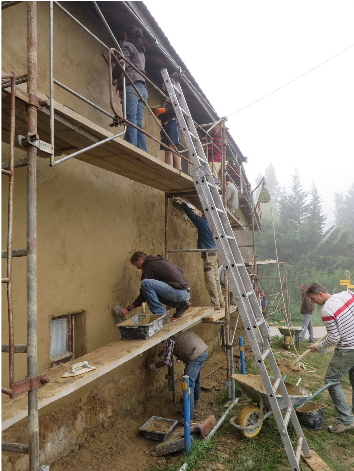
Figure 47. Chantier participatif chez Sophie et Gaël : application d'un enduit terre-fibre sur le mur nord d'une maison en pisé en cours de réhabilitation. Septembre 2015.
