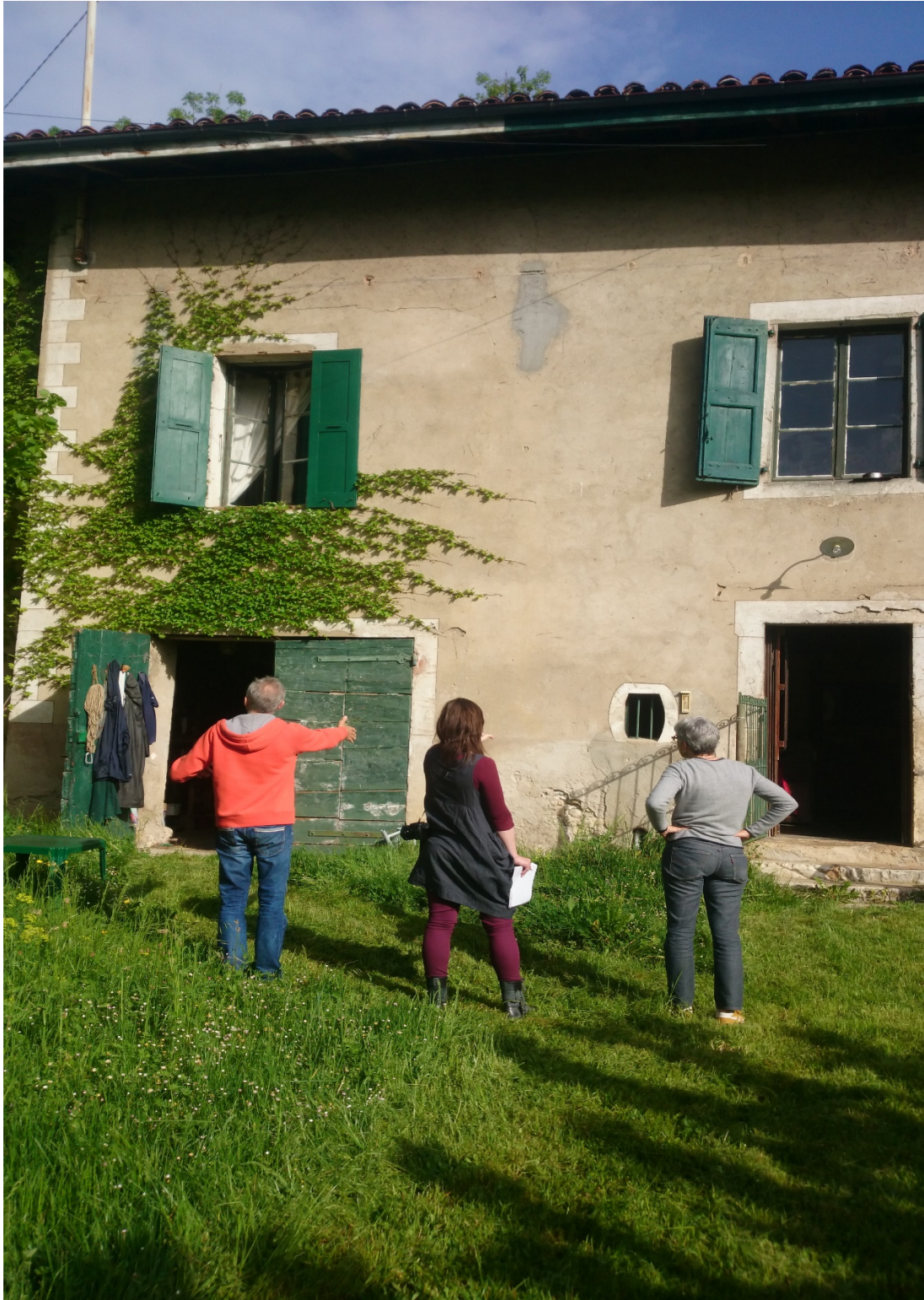
Figure 53. Diagnostic avec Julie Avons-Bariot. Avril 2018. Observation de la maison depuis l'extérieur avec les propriétaires. Chaque élément apparent sur la façade (fissures, jonctions de matériaux, traces d'humidité) est relevé par l'architecte, tout en faisant avec les propriétaires des suppositions sur son origine.
