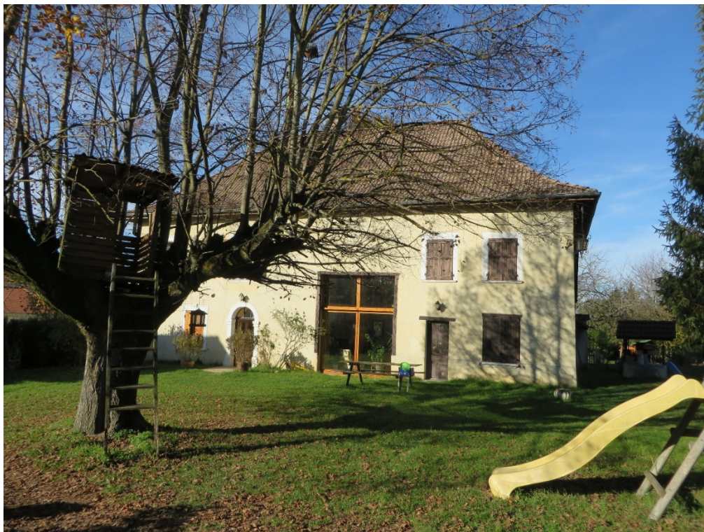
Figure 23. Photo de la maison de Gilles et Béatrice, octobre 2015.
