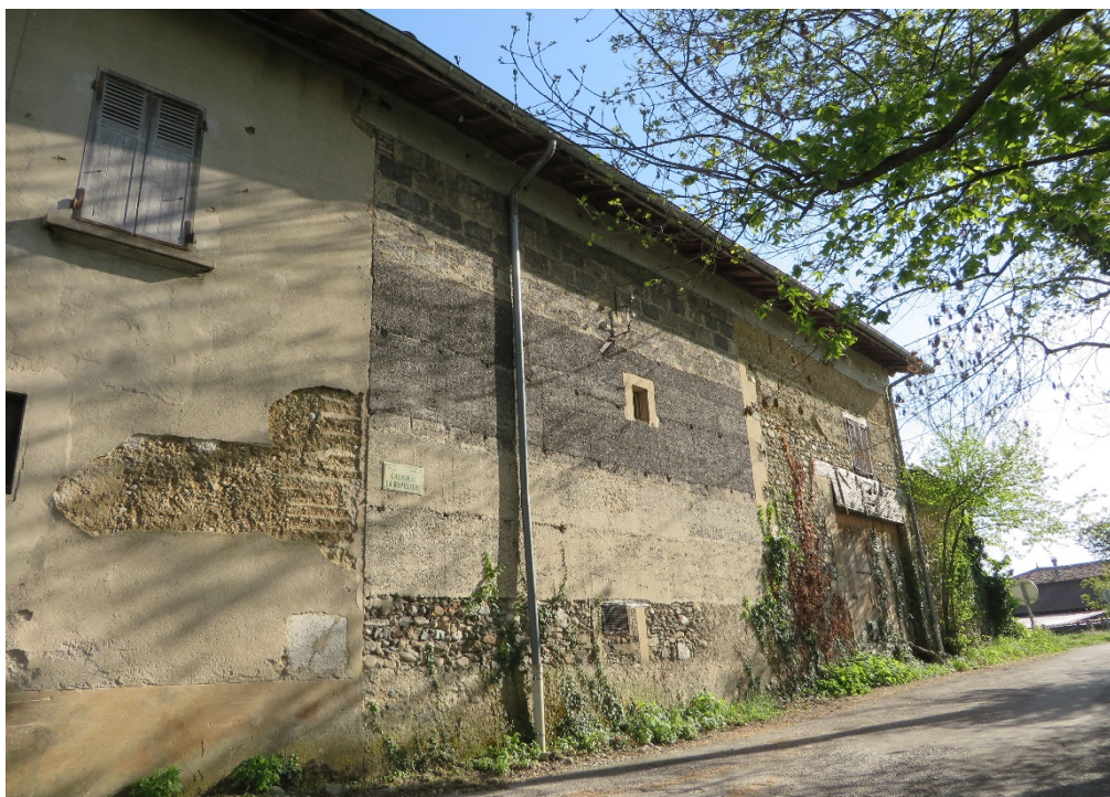
Figure 15. Bâtiment transformé à différentes époques avec différentes techniques (pisé de terre, pisé de ciment, pisé de mâchefer, béton, parpaings), Saint Cassien, avril 2014.
