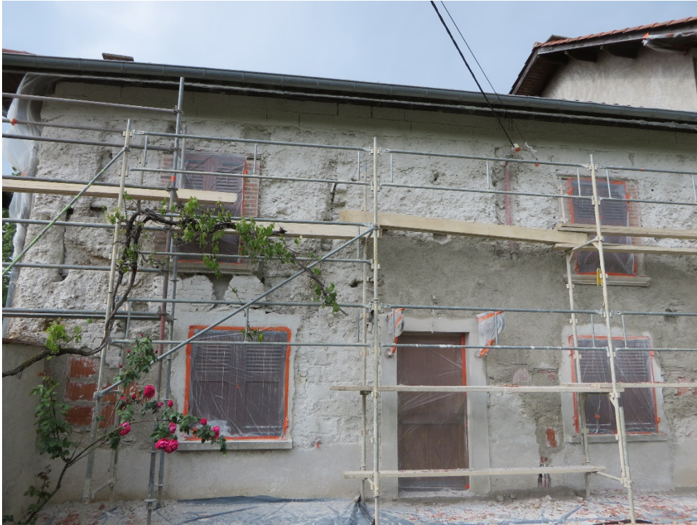
Figure 61. Chantier de C.. Mai 2016. Façade de la maison débarrassée de son enduit. Les artisans ont déjà commencé à reboucher les trous avec des briques et à projeter un gobetis sur l'ensemble de la façade.
