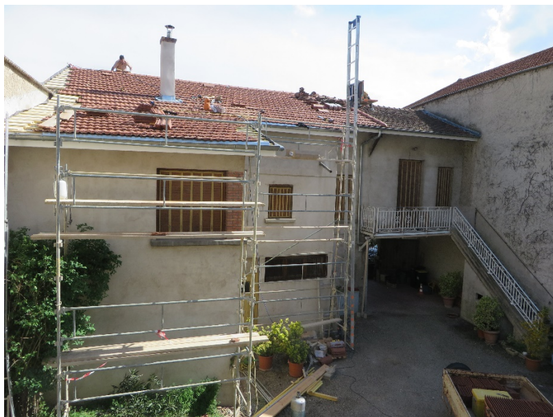
Figure 21. Vues avant et arrières de la maison d'Huguette en avril 2016, alors que des artisans sont en train de remettre la toiture en état. On peut observer les transformations vécues par la maison (ajout d'un appartement au-dessus du passage menant vers la cour et extensions de la bâtisse sur la cour).
