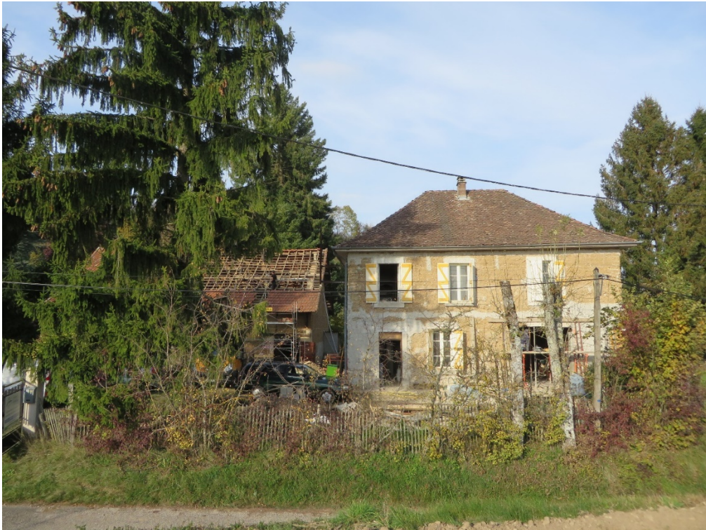
Figure 50. Maison d'Amélie et Benoît, octobre 2015, en cours de travaux. On aperçoit à gauche la grange qui abrite aujourd'hui la nouvelle chaufferie.
