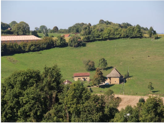
Figure 8. Ferme en pisé au détour de la route entre Valencogne et Paladru, Isère, été 2015. Photo Anne Lyse Antoine.
