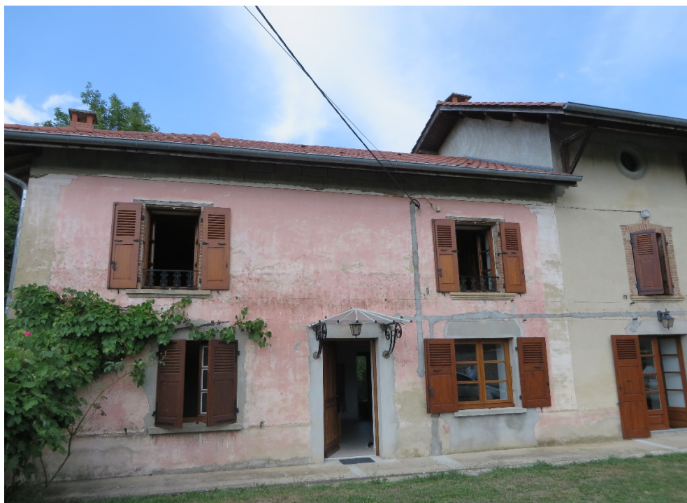
Figure 16. Maison en pisé enduite, sur laquelle on peut lire en façade différentes interventions (déplacement d'une porte, installation des réseaux électrique, rehausse sous toiture). Chatenay, juillet 2015.
