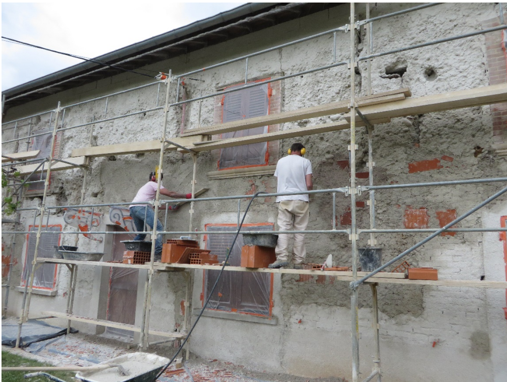
Figure 62. Chantier de C.. Mai 2016. Xavier et Jocelyn en train de reprendre la façade avec des briques et du mortier de chaux.
