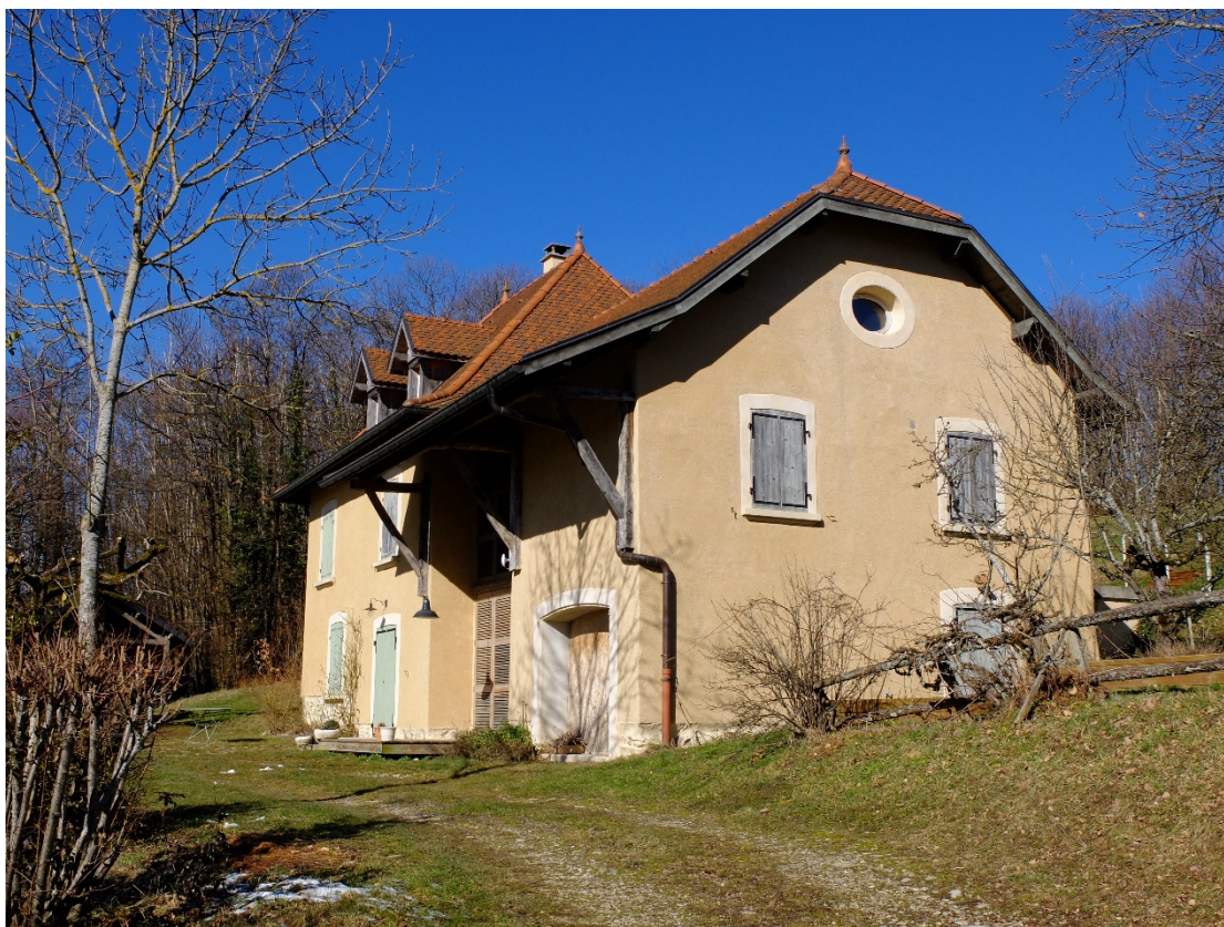
Figure 59. Réhabilitation d'une maison de famille à Valencogne. Projet conçu par Claude Salerno. Photo © Sébastien Moriset. Le projet a visé à étendre une maison d'habitation sur une ancienne grange (à l'avant sur la photo) en construisant une extension entre les deux bâtiments. Les cloisonnements intérieurs ont été préservés pour pouvoir utiliser différemment la maison selon son occupation.
