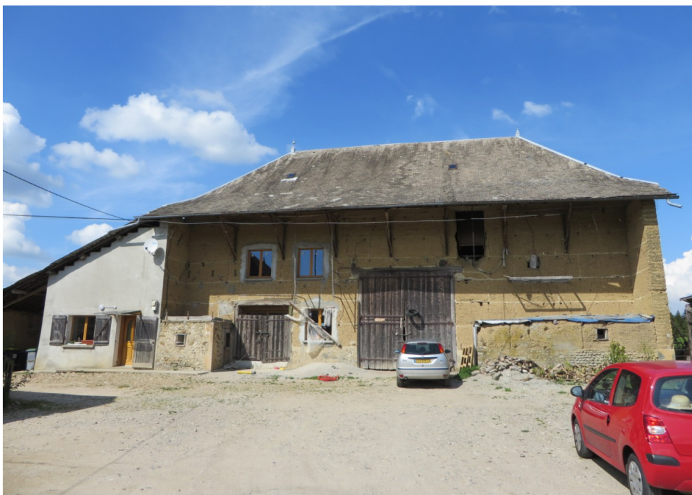
Figure 48. Maison de Magali et Paul, avril 2014. Le couple habite aujourd'hui dans la partie gauche de la maison (partie enduite), ancienne habitation qu'ils ont réaménagée. La partie centrale de la grange est en cours de travaux pour y étendre le logement.
