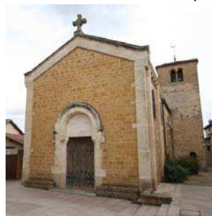
Figure 4.55 : Église Saint-Laurent (XIII e , XVIII e sacristie, XIX e nef architecte Mather), Gleizé (69).
