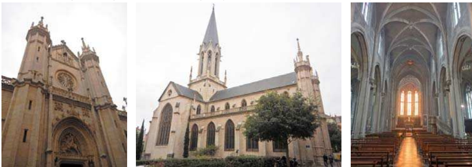
Figure 5.13 : Voûte d'ogives, église Saint-Georges (1845-1848, Pierre Bossan), Lyon 5 ème .
