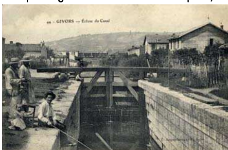
Figure 8.24 : Ecluse du canal avec le passage d'un train en arrière plan, vers 1905, Givors.
