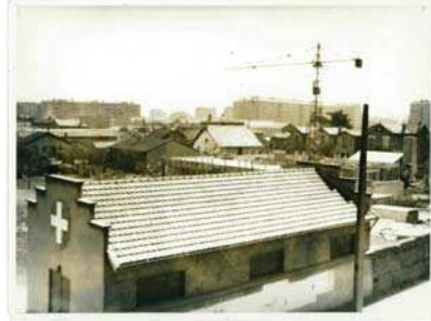
Figure 9.28 : Chapelle et chantier de l'église sous la neige, hiver 1963-1964.
