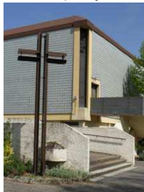
Figure 9.52 : Église Notre-Dame-de-l'Espérance, angle façade sud-ouest.
