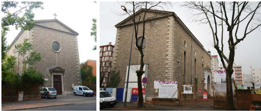
Figure 4.23 : Église du Cœur-Immaculé de Marie partiellement démolie en 2016, Villeurbanne (69).
