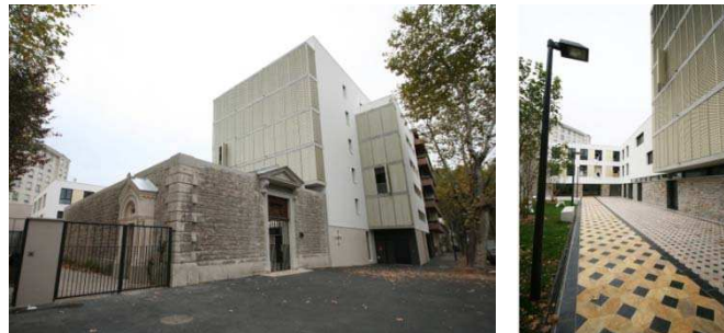
Figure 6.32 : Logements sociaux et centre d'hébergement et d'accueil, ancienne église du Cœur Immaculée de Marie (1838), Villeurbanne (69).
