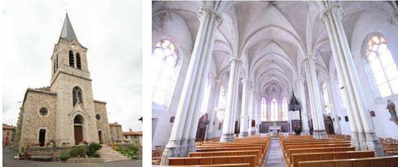
Figure 5.12 : Voûte d'ogives, église Saint-Pierre-aux-Liens (1869-1871 chœur et 4 travées Charles Antoine Favrot - 1896-1899 1 travée et clocher C.F. Meley), Estivareilles (42).
