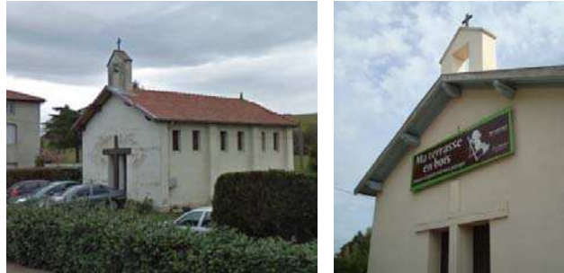
Figure 6.59 : Clément Menuiserie, ancienne chapelle Croix de Marlet (1960 environ), Unieux (42).
