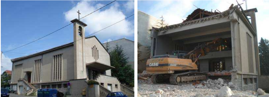
Figure 4.22 : Chapelle Sainte-Bernadette de Bel-Air démolie en 2012, Saint-Étienne (42).
