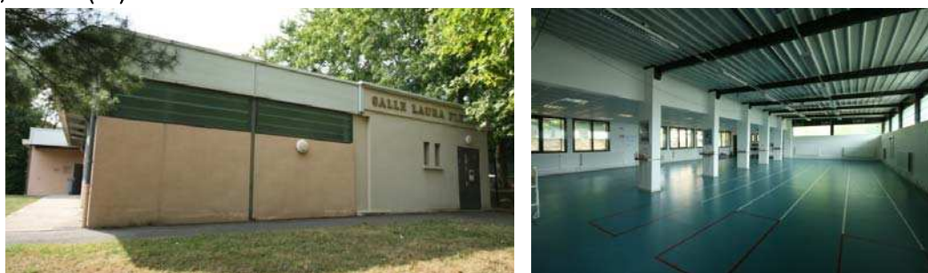
Figure 6.23 : Salle d'escrime Laura Flessel, ancienne chapelle Notre-Dame de la Cadière (1963, René Lagier), Oullins (69).
