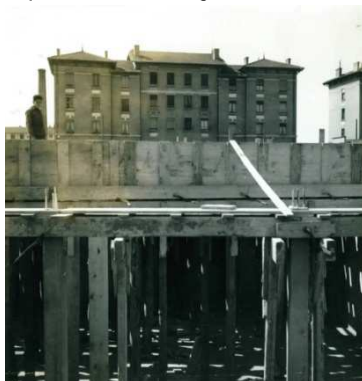
Figure 9.35 : Église Notre-Dame-de-l'Espérance, coffrage du niveau bas durant le chantier, 1964.
