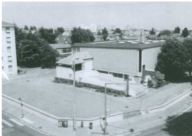
Figure 9.50 : Église Notre-Dame-de-l'Espérance, vue d'ensemble après travaux d'étanchéité.
