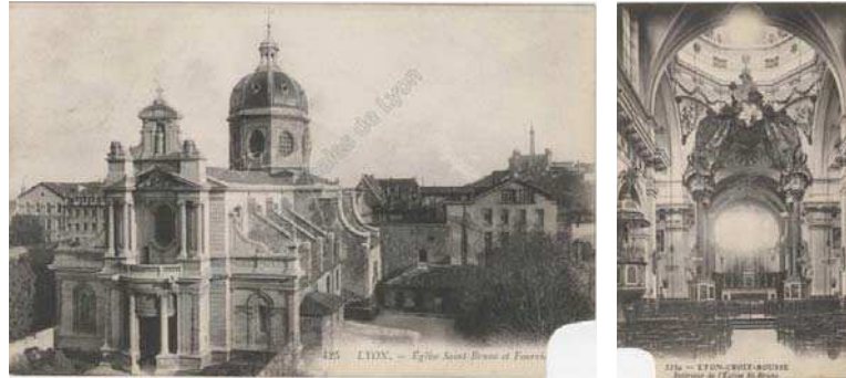
Figure 5.26 : Église Saint-Bruno-des-Chartreux (1590-1604 : chœur, 1735-1750 : agrandissement nord, 1868-1872 : façade, Jean Magnan, Ferdinand Delamonce et Sainte-Marie-Perrin), Lyon 1 er (69).
