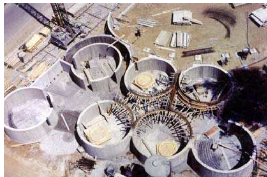
Figure 5.90 : Chantier de l'église Notre-Dame-de-Balmont (1962-1965, Pierre Genton), La Duchère, Lyon 9 ème (69).
