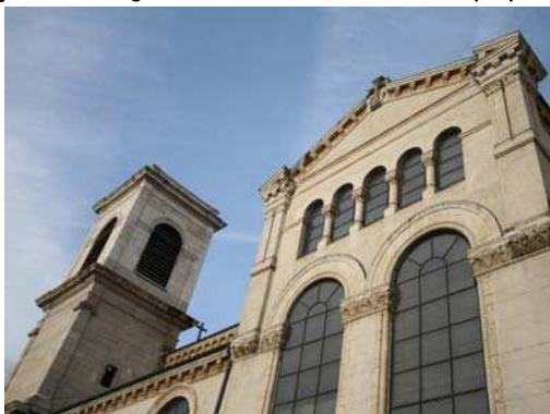
Figure 3.9 : Bien immeuble, croix sculptée sur la façade de l'église Saint-Nicolas à Givors (69).
