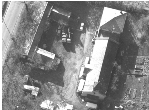
Figure 4.18 : Église Notre-Dame-de-l'Assomption, démolie en 1986, Méons, Saint-Étienne (42).
