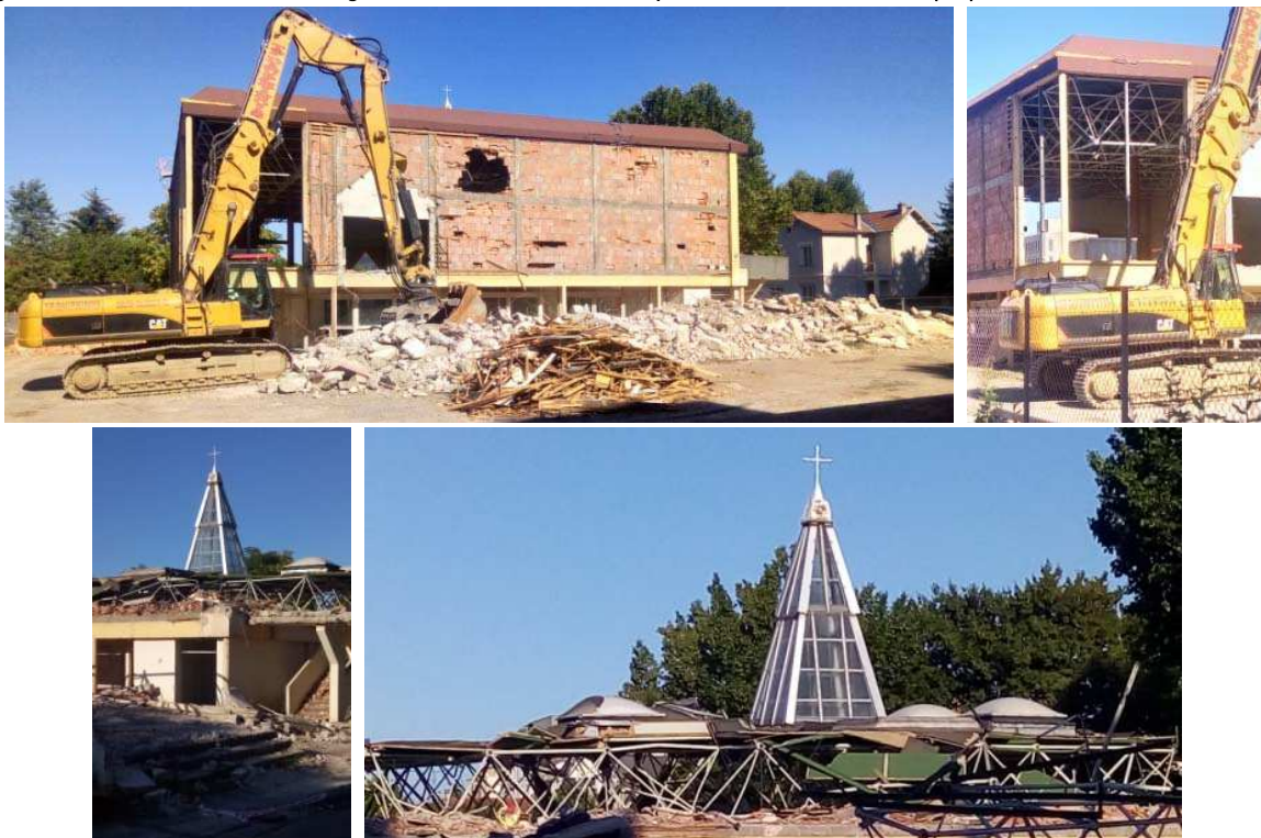
Figure 9.72 : Démolition de l'église Notre-Dame-de-l'Espérance, Villeurbanne (69).
