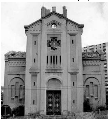
Figure 4.19 : Église Saint-Joseph démolie en 1994, Monthieu, Saint-Étienne (42).
