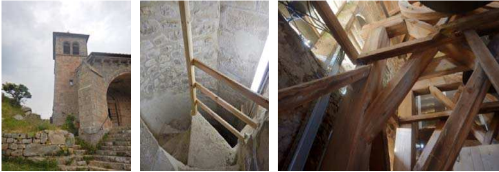
Figure 7.26 : Église de l'Assomption-de-la-Vierge, clocher, escaliers d'accès et charpente, Montarcher.
