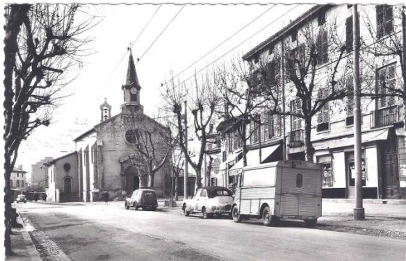
Figure 4.17 : Église Notre-Dame du Point du Jour démolie en 1971, Lyon 5 ème (69).
