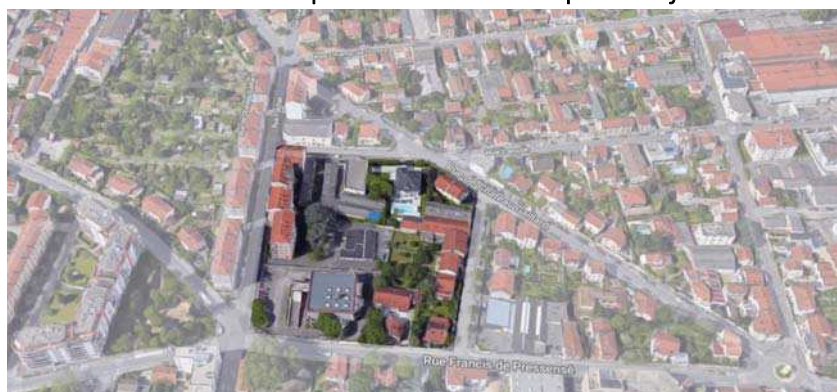
Figure 9.4 : Vue aérienne de l'îlot concerné par l'étude de la Métropole de Lyon.
