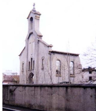
Figure 4.20 : Église Sainte-Thérèse du Creux démolie en 2004, Saint-Chamond (42).
