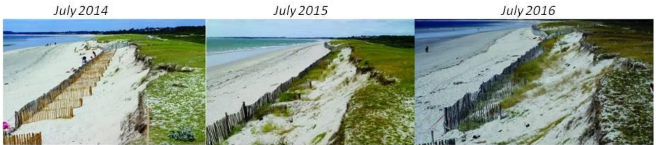
Figure 30. Expérimentation de l'outil écologique de régénération des dunes Algoxbox® (Sedrati et Cochet, 2015) – évolution visuelle du cordon dunaire entre juillet 2014 et juillet 2016 (crédit photographique : J. Cochet).
