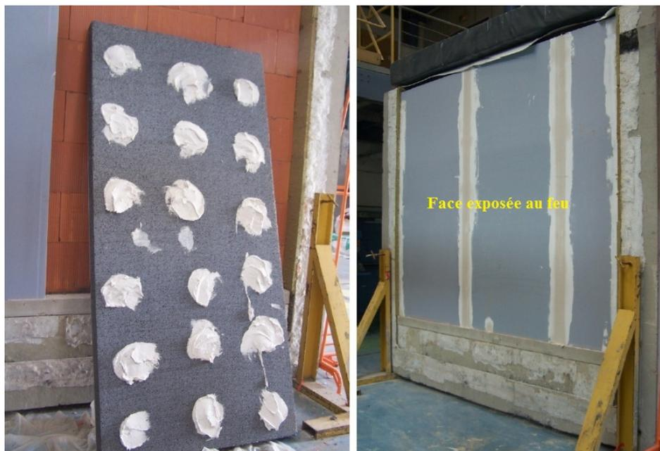
FIGURE 2.8 – Pose et calepinage des plots de colles et du doublage
