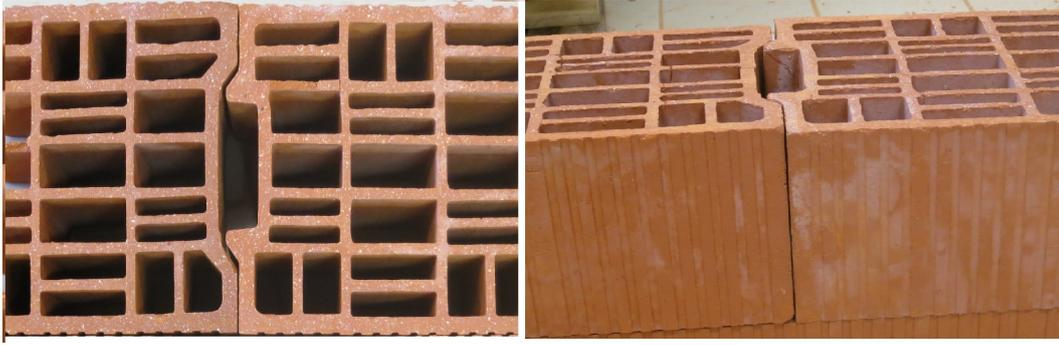
FIGURE 5.45 – Photos de l'interface entre deux briques adjacentes
