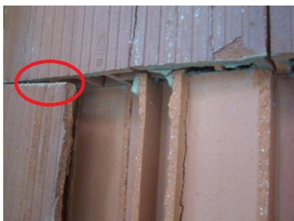
FIGURE 5.53 – Exemple d'une interface endommagée
