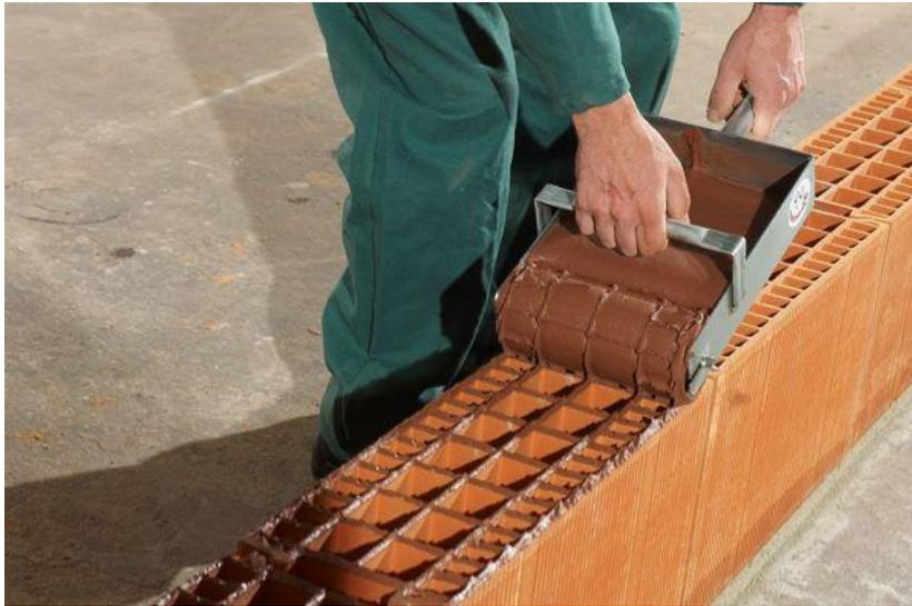
FIGURE 1.5 – Application du mortier colle lors du montage d'un mur à joints minces
