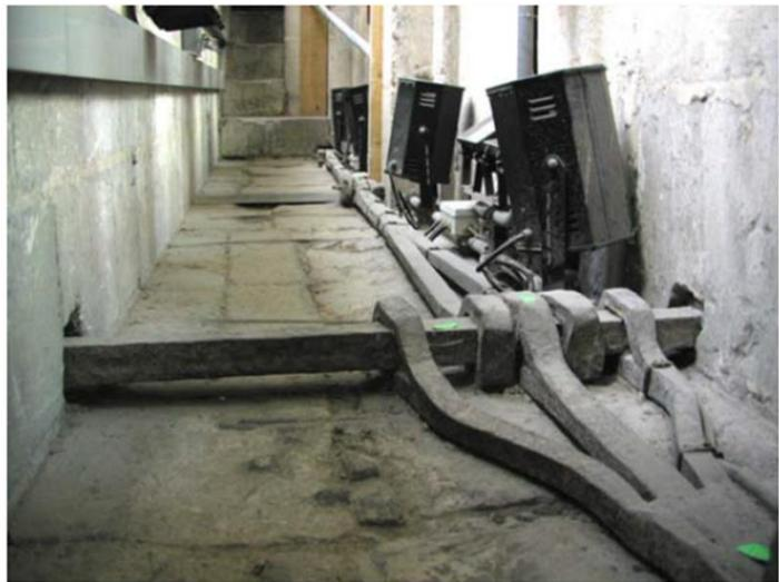
Figure 20 : a. Vue du triforium de la cathédrale d'Amiens et b. Ancrage du chaînage au niveau de la nef. Photo d'après [1].
