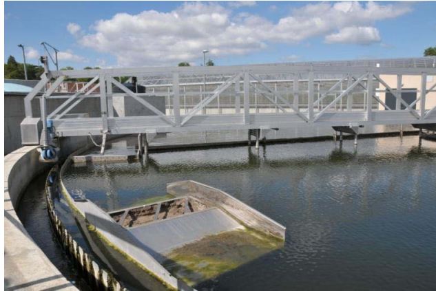
Figure I-8: Boues activées dans le bassin d'aération de la station d'épuration d'Aigueperse (63). Source : Site web SEMERAP.
