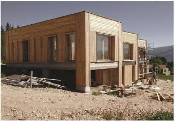
Photographie 7. Puy-Bayou : construction des logements en ossature bois et soubassement en béton et en pierres (© Boris Bouchet architectes)
