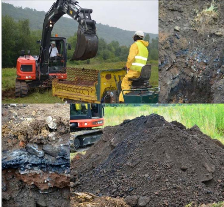
*Figure 2- 2 : Prélèvement et criblage de terre sur le site de l'ancienne cokerie de Lorraine (MG) (Juillet 2014)*
