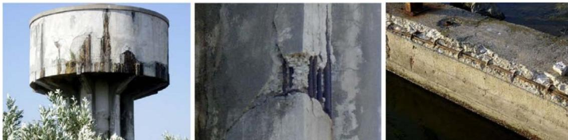
**Figure I-1 Exemples de structures en béton armé corrodées [12]**
