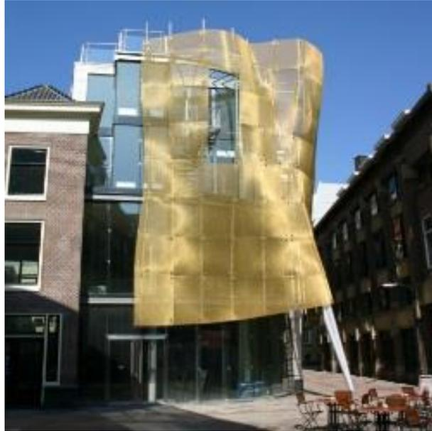
Figure 1-31 : photographie d'une œuvre architecturale jaune dorée, grâce à un revêtement de nitrure de zirconium. La Haye, Pays-Bas.
