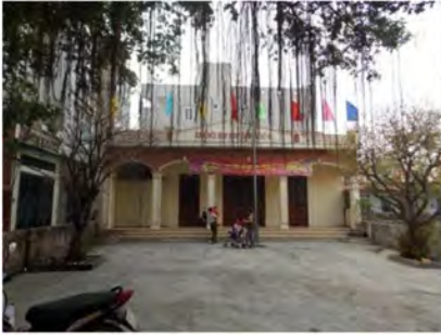
01 : Ce sont ici les premières terres d'habitation – il y a longtemps – du hameau Trại. Si, avant 1950, c'était un grand lac, aujourd'hui, se dressent le banian et des maisons.
