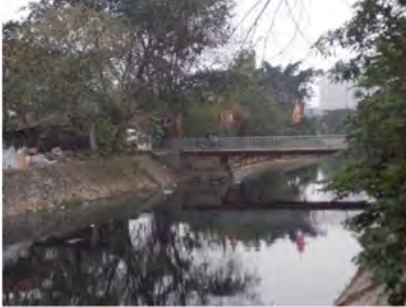
18 : La vue du pont de loin. Il n'est aujourd'hui qu'un simple moyen de circulation, dépourvu de forme architecturale et de valeur spirituelle. Il devrait avoir l'architecture caractéristique d'un temple et des anciens villages traditionnels. Les deux quais sont en béton, l'eau prend une couleur noire.
