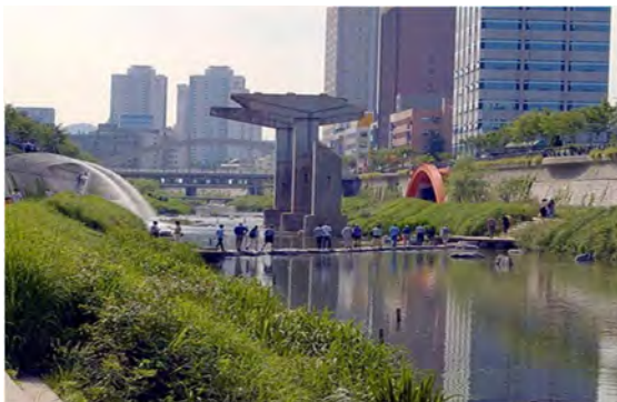
Photo : Patrimoines sauvegardés et en partie restaurés du poteau de l'autoroute jadis bruyante, sur le lit de la rivière. 1
