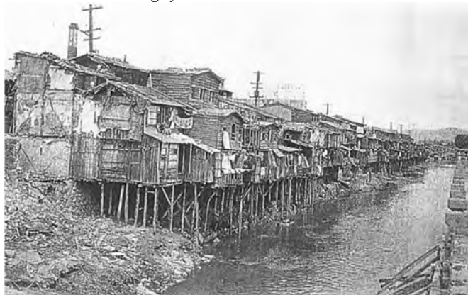
1910-1945, l'image de l'époque de première urbanisation : deux berges de la rivière ont été occupées par des constructions précaires sur pilotis tournant le dos et jetant des eaux usées dans le cours d'eau. 4
