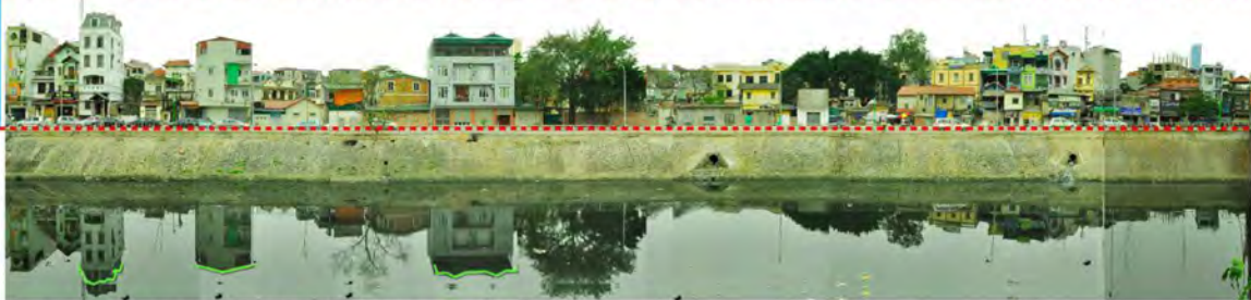
Façade principale de l'orientation F
