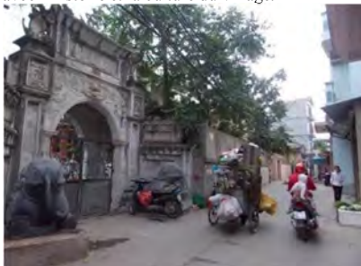
17 : La porte d'une maison d'habitation dans le village, construite comme celle d'un propriétaire terrien d'autrefois ; sur les deux côtés de la porte, se trouvent deux éléphants assis en pierre, symbolisant la puissance (la richesse) du propriétaire.
