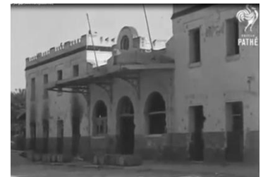
Figure 27 _ La Gare après les bombardements _ Vidéo Pathé _
