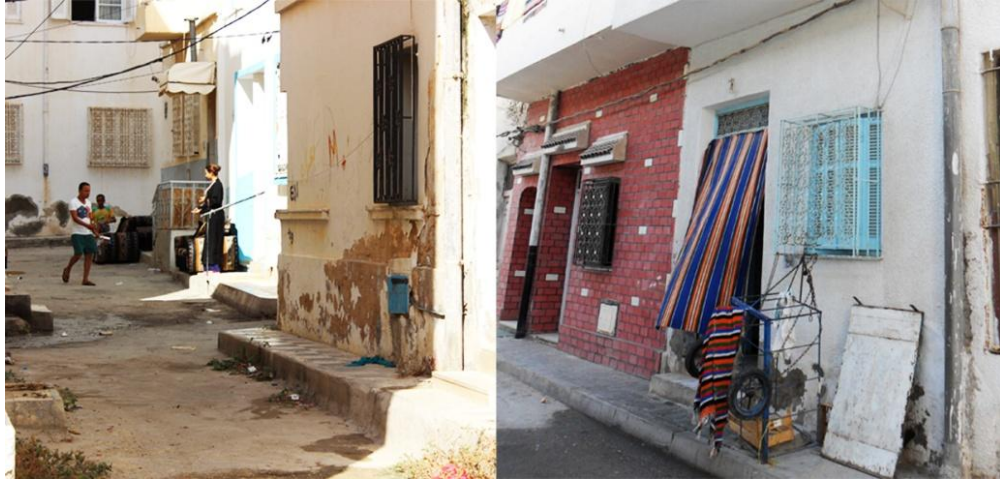
Figure 236_ Capaci Grandi _ 2015 _ Capaci Piccolo _ 2012_
