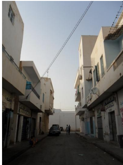
Figure 96 _ Habitat à l'étage et commerce et services au rez de chaussée _ Rue de Nabeul _ Capaci Piccolo _ Photo crédit de l'auteur _ 2012_
