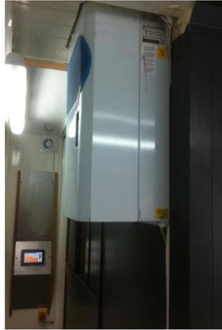
Figure 31 : Climatiseur pour le refroidissement du sas
