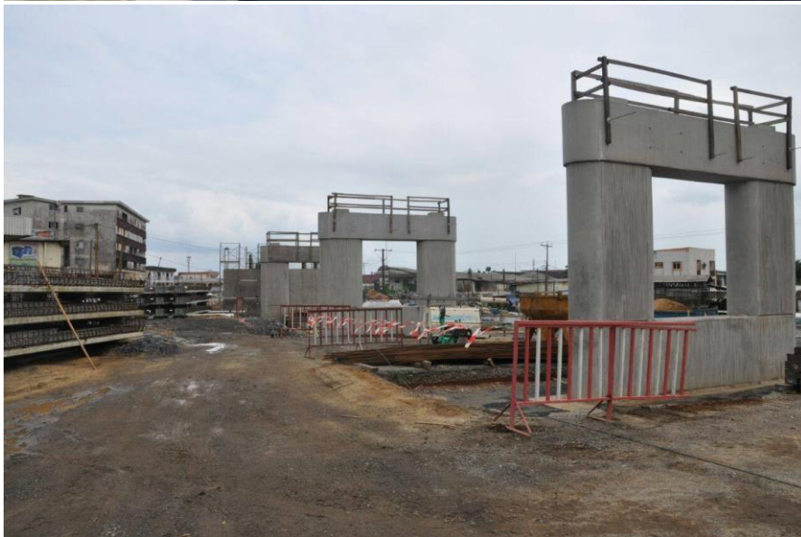
Photo 42 : Travaux d'aménagement de l'entrée Ouest et Est de Douala © ministère des travaux publics du Cameroun 2015
