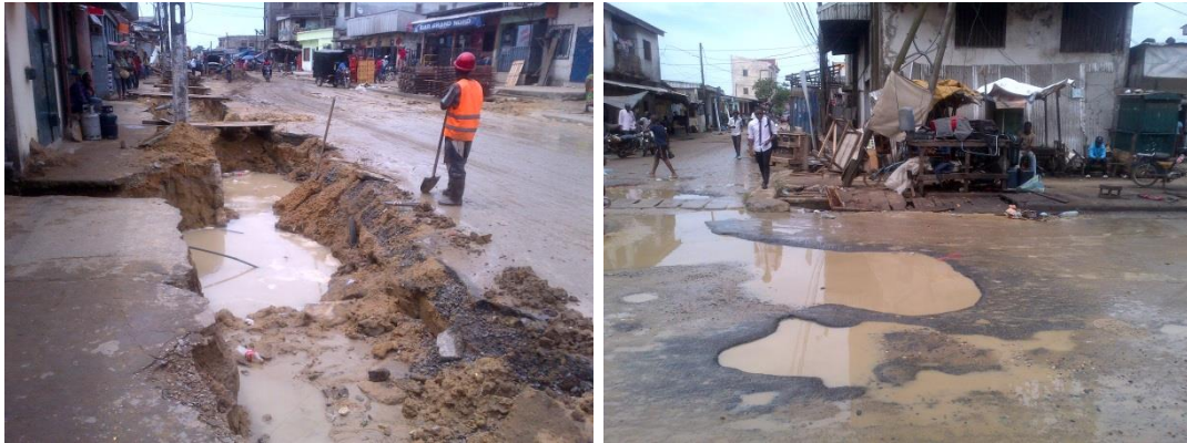
Photo 9 : Travaux de réhabilitation de la voirie à Douala © Kalieu 2015
