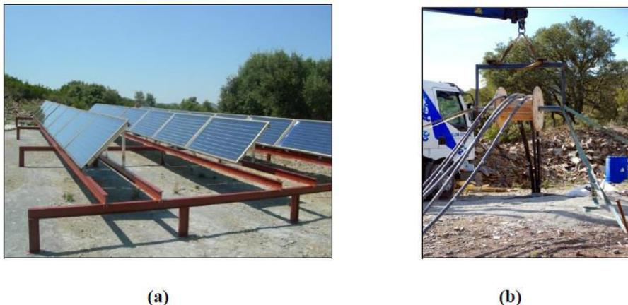
**Figure 1. 16 : Installation expérimentale de : (a) champs des panneaux solaire, (b) sondes géothermiques (Delaleux et al. 2012).**
