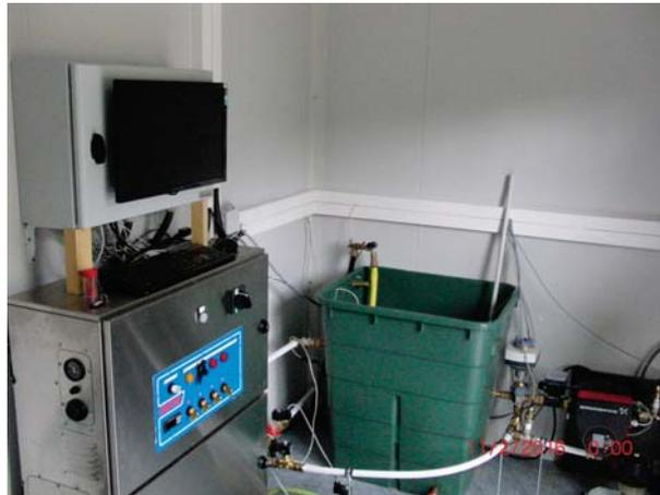
Figure 4.6: Vue de la chaudière, de l'ordinateur de pilotage et de la cuve tampon
