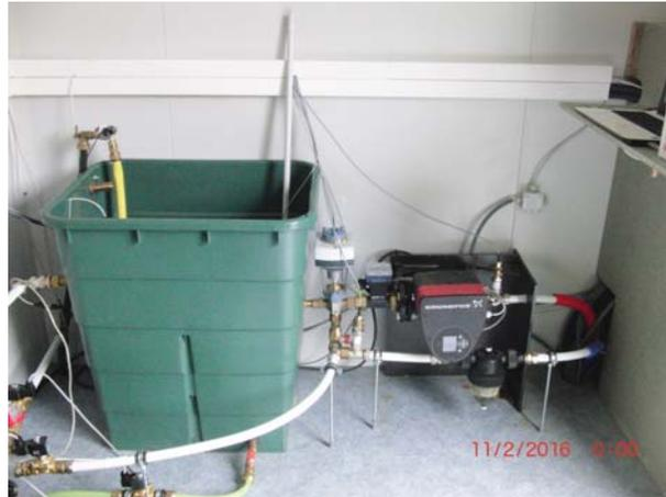
**Figure 4.7:** Vue de de la cuve tampon, de la vanne « 3 voies », du débitmètre, du circulateur et du filtre
