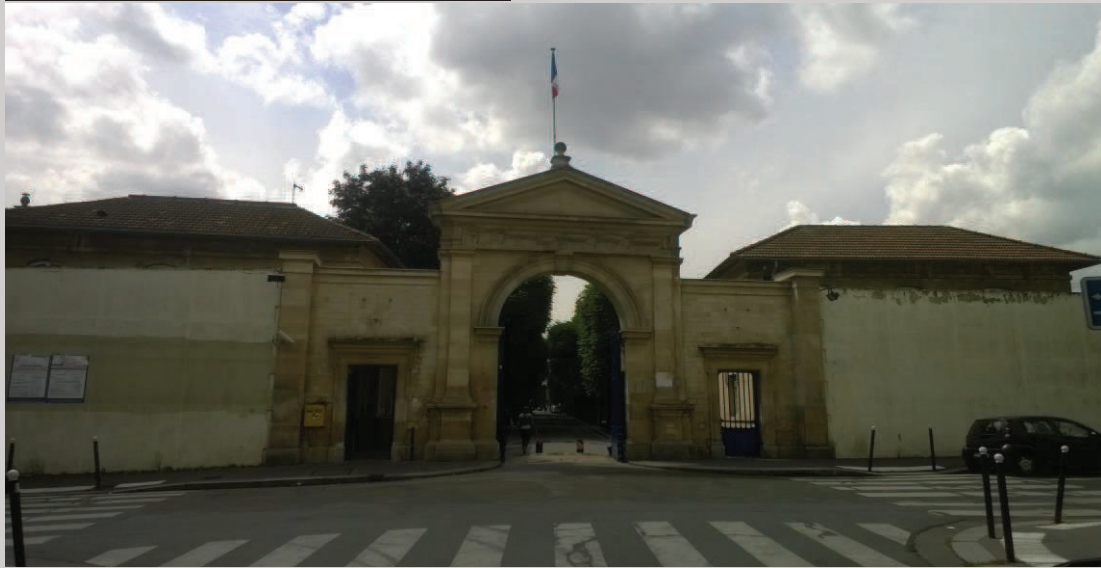
Photo n° 1 : l'entrée de l'établissement
