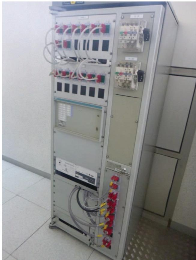
Figure II-18 – Photo de l'oscillo-perturbographe avec en entrée les tensions, courants de chaque phase ainsi que le courant homopolaire
