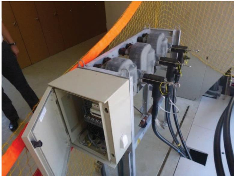
Figure II-19 – Photo de l'armoire de protection (au premier plan) et des transformateurs de tension (au second plan)
