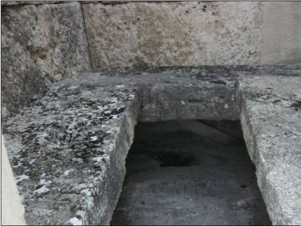
Figure 75 : escalier et banquettes ; intérieur de la chambre supérieure de la tombe 163d Sources : cliché V. Arnesano
