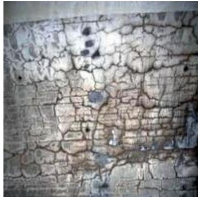
**Figure I.4** : Mur en béton faïencé sous l'effet d'une réaction alcali-granulat [24].
