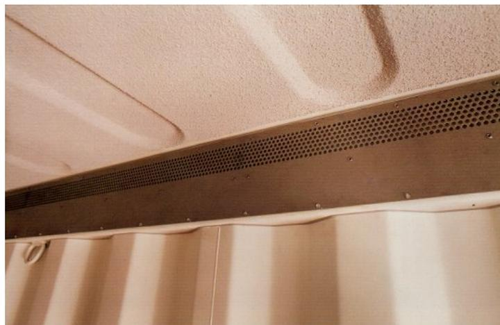
FIGURE 3 – Ventilation d'un conteneur
