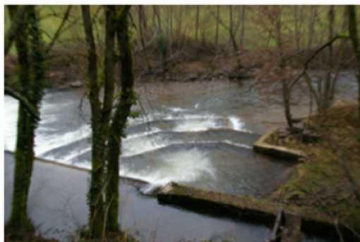
FIGURE 4.9: Exemple de prébarrage (Source : MIGADO, 2008b)
