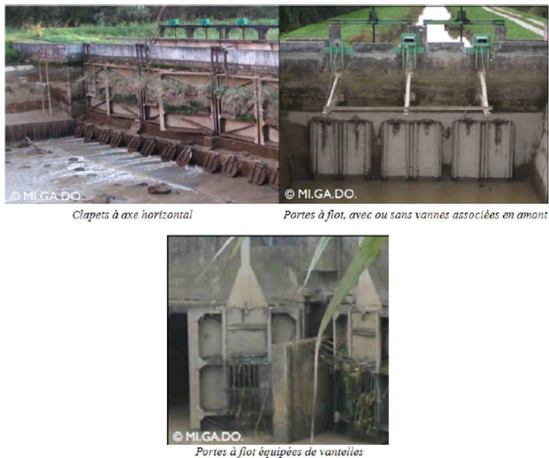
FIGURE 4.14: Principaux ouvrages de protection à la mer (Source : MIGADO, 2008b)
