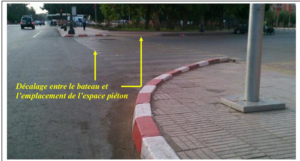
Figure 57. Marrakech, passage piéton situé à côté de l'abaissement du trottoir. Cliché : A. NAKHLI, 2010.
