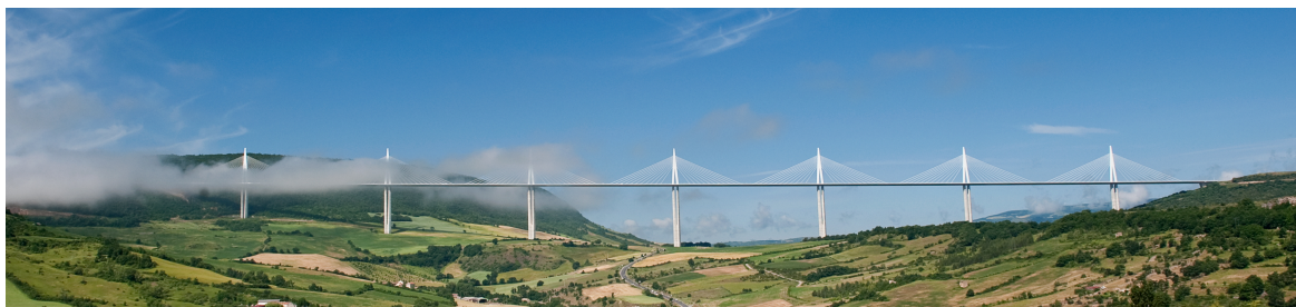
FIGURE 1.1 – Viaduc de Millau
