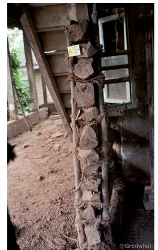
Système en *zagmeh* : stabilisation par clés verticales
