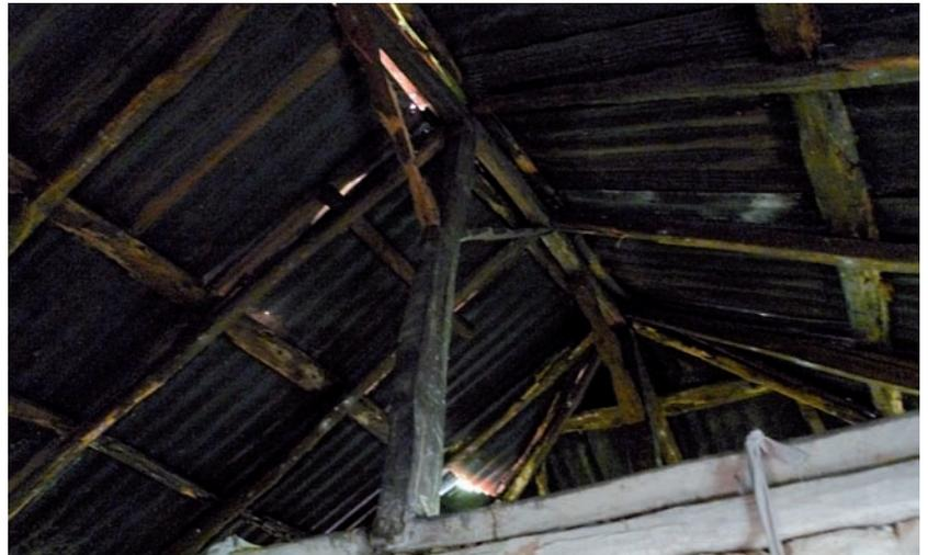
Des contreventements horizontaux aux quatre angles de la poutre sablière solidarisent la structure, tandis qu'au niveau de la toiture, des contreventements diagonaux entre la poutre faîtière et les pignons des fermes assurent la stabilité de la charpente.
