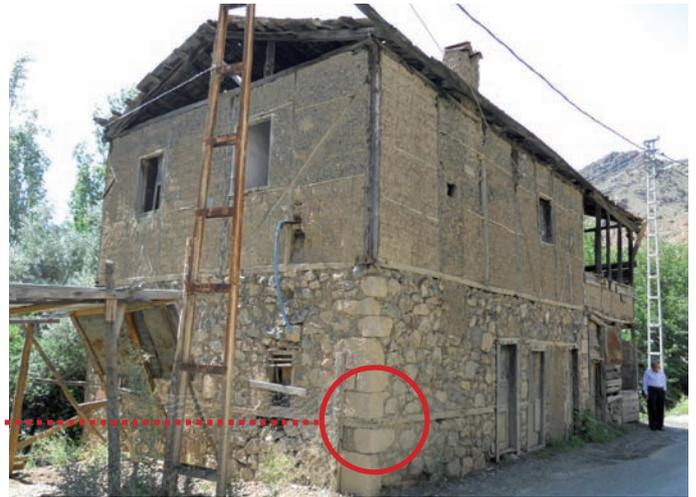
rez-de-chaussée en maçonnerie en pierre avec mortier en
