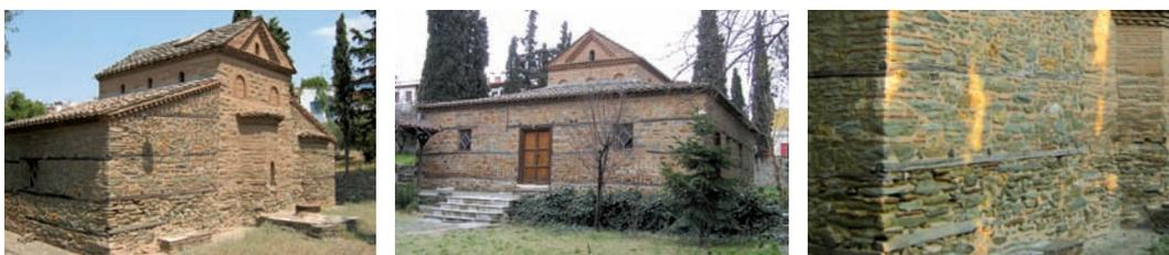
Fig.114: Basilique de Agios Nikolaos (Thessaloniki, Grèce) : a) déambulatoire avec insertions adossé au corps principal en maçonnerie simple, b) façade principale, c) détail des insertions horizontales en bois (crédits a et b: Buchhändler ; source c: a3-3gymthes.blogspot.com)
