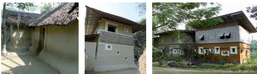
Fig.14: Bangladesh, réinterprétation de la construction en terre et bambou :
