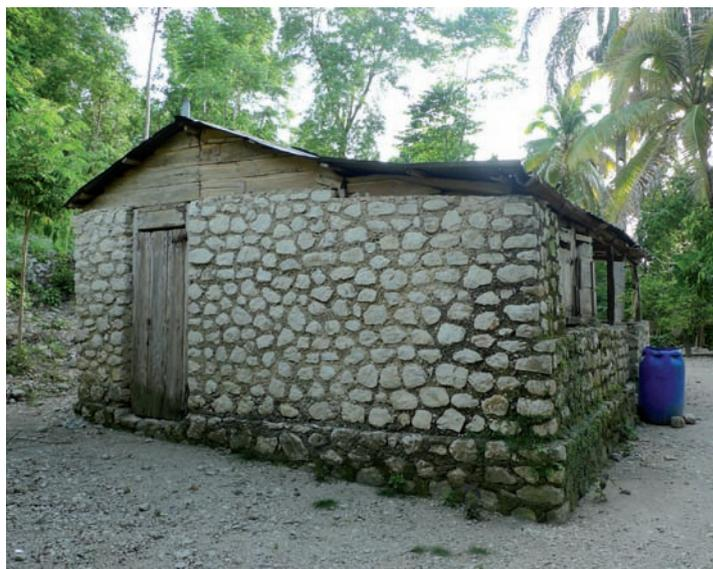
Structure en poteaux avec remplissage/parement en maçonnerie de pierres. La maçonnerie recouvre la structure en bois qui reste noyée à l'intérieur du mur.
