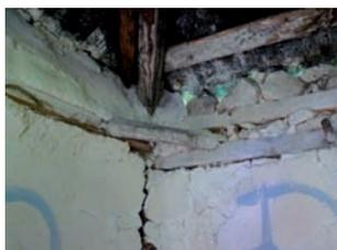
Exemple : la faible hauteur sous toiture des habitations rurales haïtiennes limite la prise au vent et, déplaçant le barycentre de la construction vers le bas, favorise une bonne résistance aux séismes. En outre, des contreventements horizontaux aux quatre angles de la poutre sablière (Fig. 137b) solidarissent l'ossature en bois envers des sollicitations induites aussi bien par des vents violents que par des tremblements de terre (analyse de terrain 2012).
