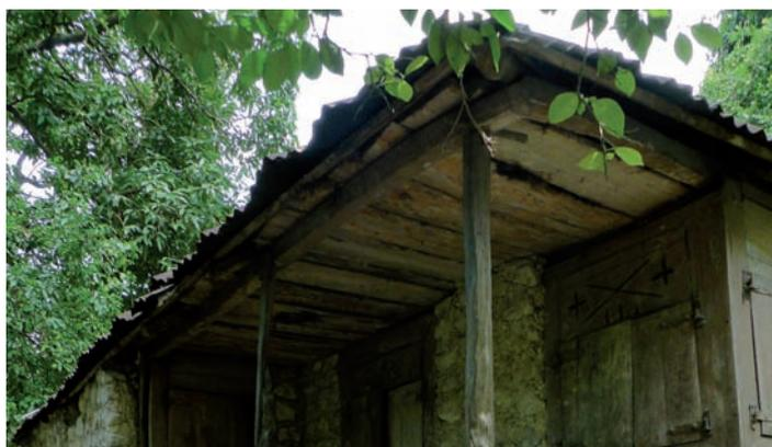
Outre à être un endroit permettant la mise en sécurité des biens (envers les voleurs et l'humidité), le grenier fermé apporte une majeure résistance à la toiture, en particulier dans le cas d'une couverture à deux pentes.
