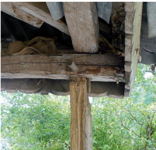
Des assemblages par tenon et mortaise permettent au bâtiment de subir des légères déformations, tout en gardant une cohésion structurelle.
