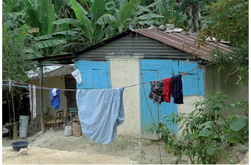
La faible hauteur sous toiture limite la prise du vent mais, en déplaçant le centre de gravité vers le bas, favorise également une bonne résistance aux séismes.
