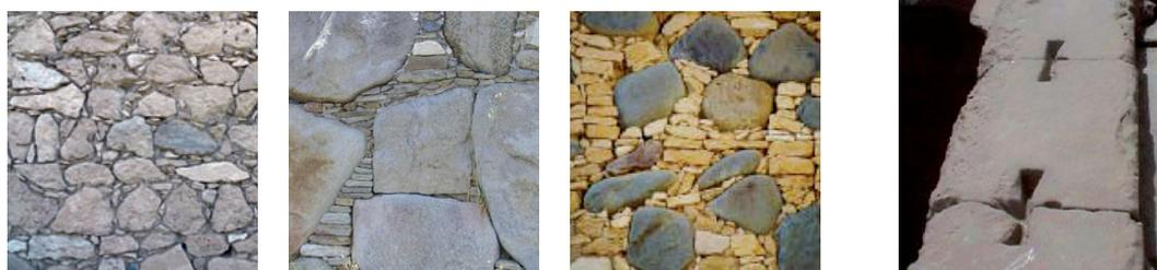
Fig.110: Bourrage : a) en joints fins, Kadibükü (Turquie) ; b) en piles, Délos (Grèce, source: Wikipedia) ; c) étendu, Chypre (source: MEDA CORPUS, 2011)
