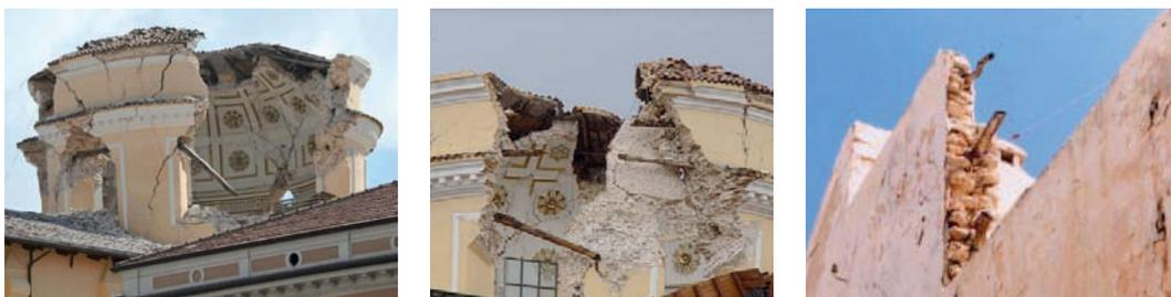
Fig.115: Insertions en tirant en bois : église de Santa Maria del Suffragio après le séisme de 2009, L'Aquila (Italie) : a) vue de la coupole (source: focus.de) et b) détail des insertions (source: LAGOMARSINO, 2012) ; c) tirants en bois dans maçonnerie en pierre brute hourdée, Tunisie (source: MEDA CORPUS, 2011)
