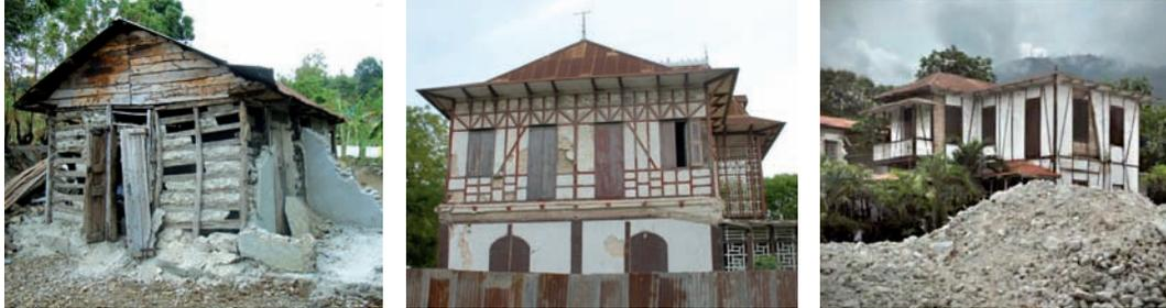
Fig.86: Haïti, effets du séisme de janvier 2010 : a) habitat rural (crédits: A. Douline) ; maisons *gingerbread* (Port-au-Prince) : b) chute de portions de remplissage de l'ossature (crédits: S. Kelley), c) bâtiment faiblement endommagé derrière le reste d'un structure en béton armé (crédits: R. Langenbach)
