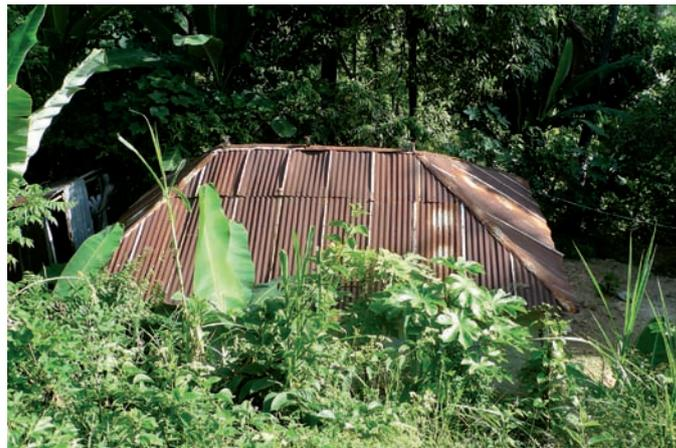
La toiture à faible pente et à 4 pans ainsi que des débords de toiture réduits permettent de diminuer la prise du vent. En outre, les habitations sont généralement entourées de végétation, ce qui diminue l'impact des vents violents.
