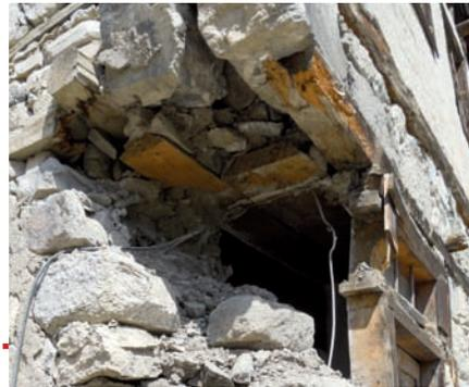
chaînage constitué par deux poutres parallèles reliées par des traverses. En cas de défaillance de la maçonnerie en dessous il empêche l'effondrement de l'étage
