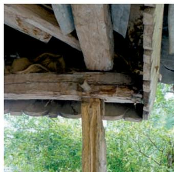
Assemblage par tenon et mortaise
