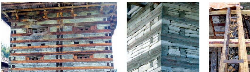
Fig.124: Construction *kath-khuni / koti banal* (Inde) : a) principe structurel (source : RAUTELA, JOSHI, SINGH, ET AL., 2008) ; b) superposition aux angles ; c) traverse de connexion entre les poutres (crédits b et c: J. Thakkar)
