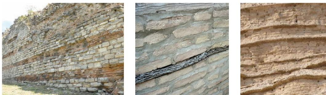
Fig.123: a) bandes en briques cuites entre rangées en maçonnerie de pierres (mur théodosien, Istanbul) ; nattes en roseaux dans maçonnerie en briques de terre crue : b) Turkménistan (crédits: D. Gandreau) et (c) ziggourat Dur-Kurigalzu en Irak (crédits: T. J. Tritten)
