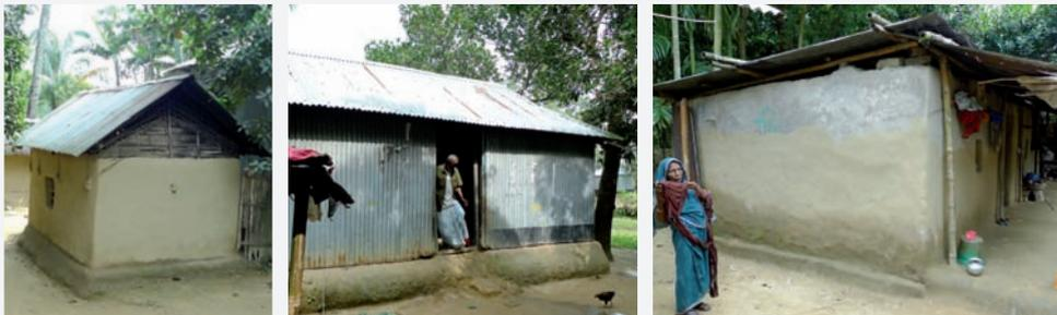
Fig.44: a) construction en terre massive ; b) nouvelles pratiques constructives ; c) réparation d'une habitation en terre crue suite à une inondation
