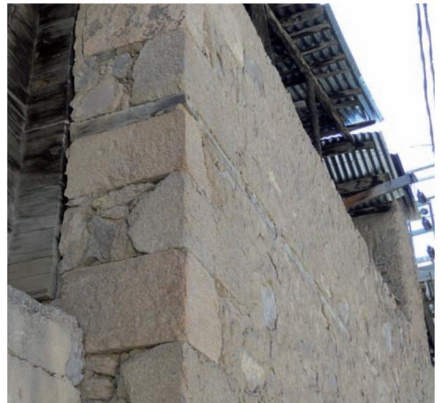
maçonnerie en pierre sèche avec chaînage horizontal
