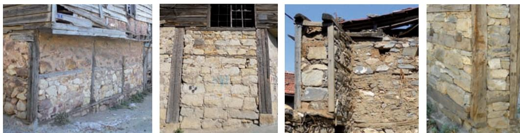
Fig.127: Insertions horizontales et verticale (Turquie) : a et b) en portique ; c et d) en gabion
