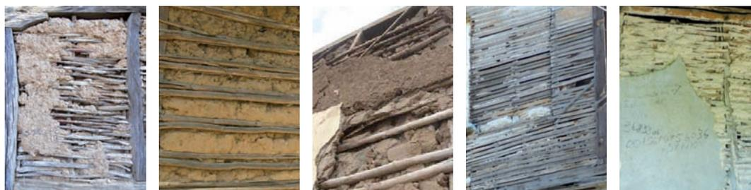
Fig.102: a) torchis (Turquie) ; b) remplissage en terre confiné (Guatemala, crédits: M. Mas Gomes) ; c) *taquezal* avec gravat (Nicaragua, source: QUINTALLET, SAMIN, 2012) ; d) *bağdadı* (Turquie) ; e) effet du séisme de 2010 sur un panneau en clissage avec mortier de terre chaux (Haïti)
