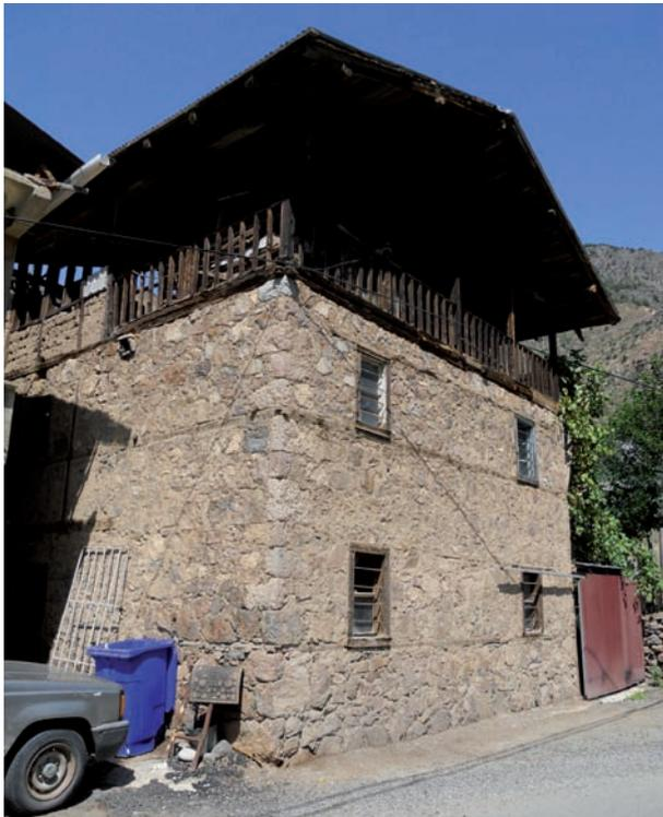
étages inférieurs en maçonnerie en pierre avec
