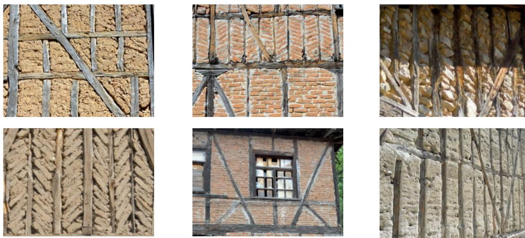
Fig.99: Variantes de remplissage et de répartition de la structure primaire (*hımış*, Turquie) :
