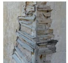
lattis avec remplissage en pierres et mortier de terre
