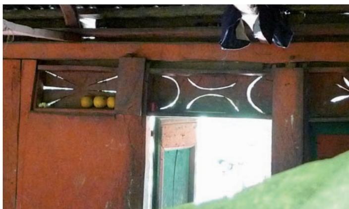
Au-dessus des ouvertures, des planches en bois entaillées permettent une ventilation des pièces mais surtout, en cas de cyclone, permette d'égaliser la pression intérieure et extérieure, réduisant le risque d'un arrachement de la toiture.
