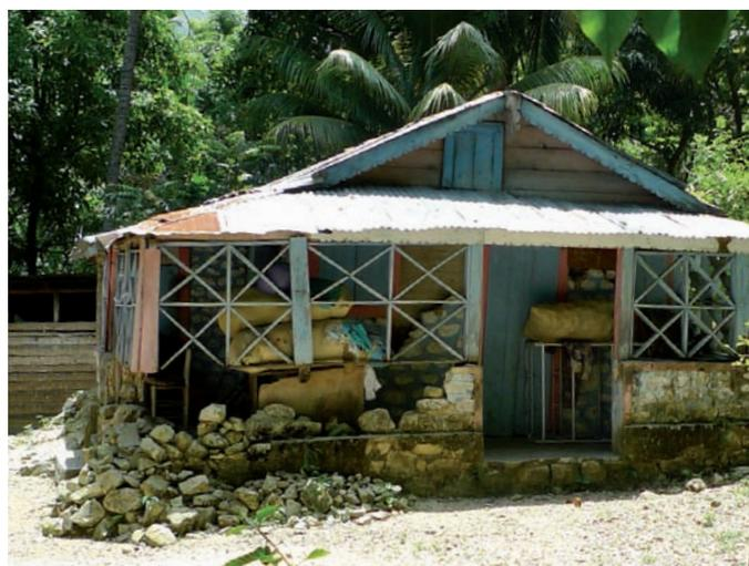
La clôture de la galerie avec des planches en bois positionnées en croix solidarise la structure qui, même en cas d'écroulement du soubassement en maçonnerie, maintient une certaine cohérence sans s'effondrer.
