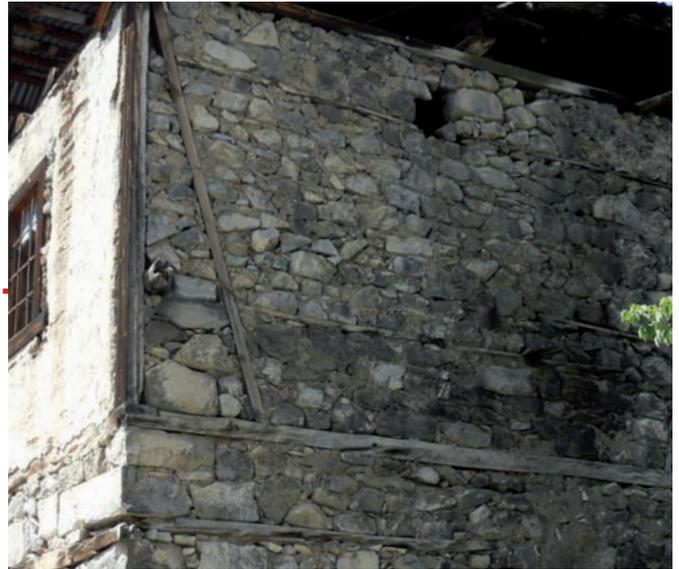
rez-de-chaussée en maçonnerie avec chaînages en bois, étage en maçonnerie en pierre avec planches horizontales en bois et angles renforcés par des poteaux et diagonales
