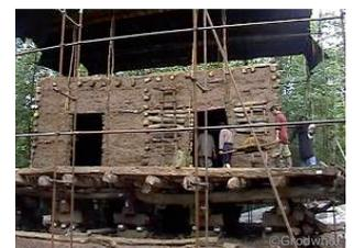
Système en *zagmeh* : boîte continue surélevée et remplissage avec un mortier en terre fibrée
