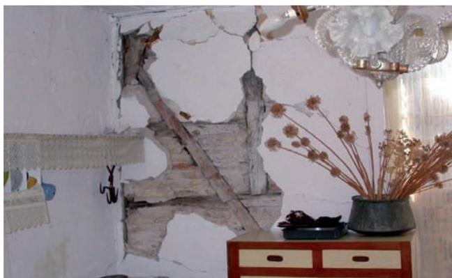
Effets du séisme du 14 août 2003 : détachement de l'enduit et fissuration de la maçonnerie au rez-de-chaussée
