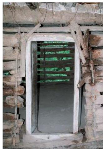
Système en *zagmeh* : stabilisation par clés verticales et cales en correspondance des ouvertures
