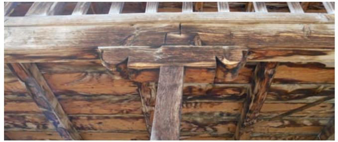
charpente / tête de poteau avec élément de répartition des charges et assemblage à mi-bois de prolongation des poutres
