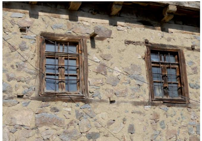
traverses de connexion entre poutres horizontales avec prolongement consolidant l'ancrage entre les éléments
