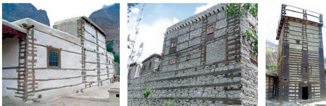
Fig.126: Construction *cator and cribbage* (Pakistan) : a) fort Baltit (crédits: T. Schacher) ; b) fort Shigar avec socle en insertions espacées (source: ismaili.net) ; c) fort Altit, tour Shikari datant d'environ 1100 ans présentant un socle avec renforcement du confinement par rapprochement des insertions (crédits: Plhiggs- Wikimedia Commons)
