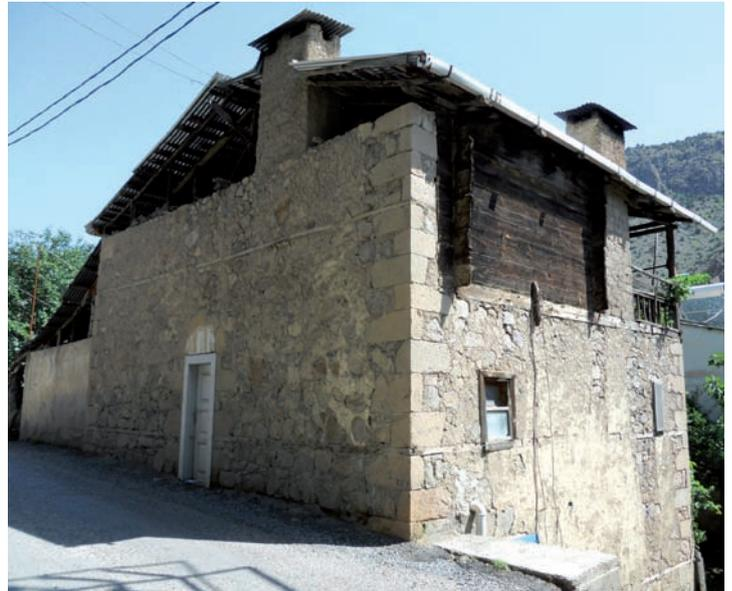
mur trumeau avec chaînage horizontal en bois
