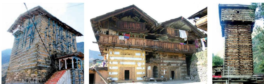
Fig.125: Variantes de construction *kath-khuni / koti banal* : a) avec clés verticales de stabilisation (source : hrishichandanpurkar.blogspot.ch) ; avec dernier étage en porte-à-faux en ossature bois (source: RAUTELA, JOSHI, SINGH, et al., 2008) et (c) en maçonnerie avec insertions (crédits: T. Schacher)
