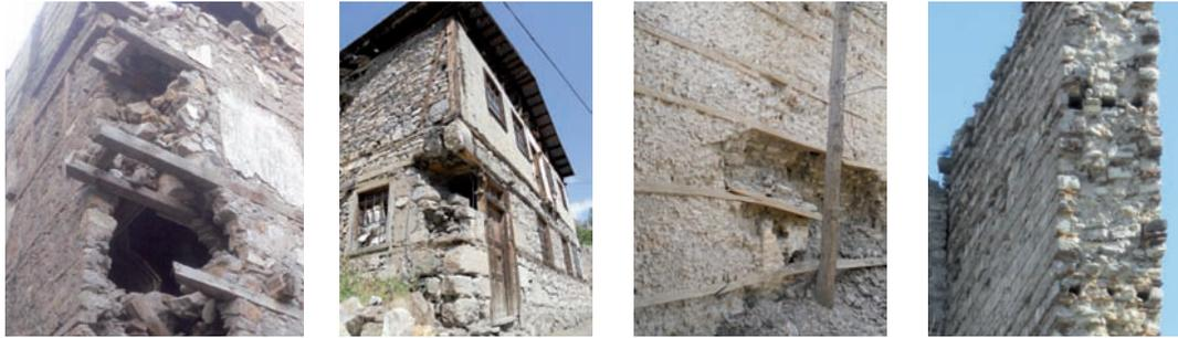
Fig.120: Insertions en échelle (Turquie) assurant la stabilité du mur (a) et des étages supérieurs (b) en cas de défaillance localisée aux angles ou dans le plan du mur (c) ; d) le mur théodosien présente des traces d'insertions horizontales selon le même principe mais avec triple poutre (Istanbul)
