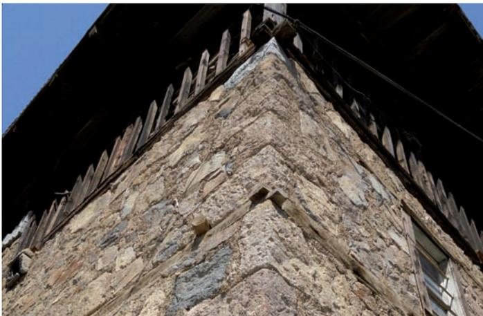
assemblages / connexions entre chaînages perpendiculaires
