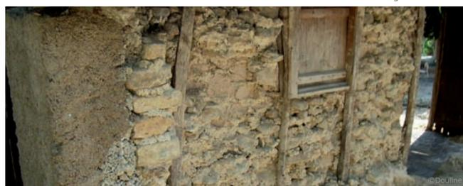
Écroulement de la face externe du mur lors du séisme de 2010
