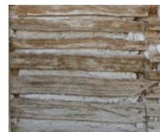
lattis cloués remplis avec du mortier en terre et/ou chaux
