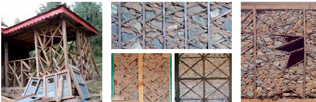
Fig.100: Cachemire pakistanais, *dhajji dewari* : a) structure vide ; b, c et d) variante de remplissage ; e) dégâts suite au séisme de 2005 (crédits : a, b et e) T. Schacher ; source : c et d) HIÇYILMAZ, BOTHARA, STEPHENSON, 2011)
