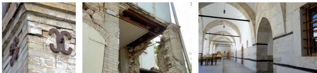
Fig.116: Insertions en tirant métalliques : maisons *gingerbread*, Port-au-Prince (Haïti, source: LANGENBACH, KELLEY, SPARKS, ET AL., 2010), (a) plaques d'ancrage et (b) dégâts sans effondrement complet lors du séisme de 2010 ; c) association entre tirants métalliques et insertions horizontales en bois dans le caravansérail Cinci Han, Safranbolu (Turquie)
