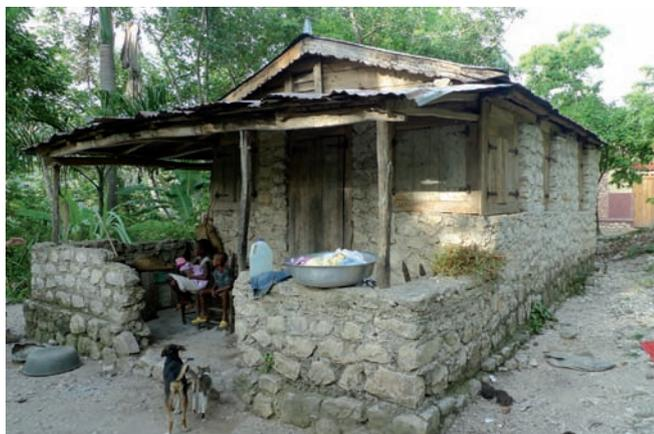
Structure avec poteaux en bois et remplissage en maçonnerie en pierre (*tiwoch*) :
