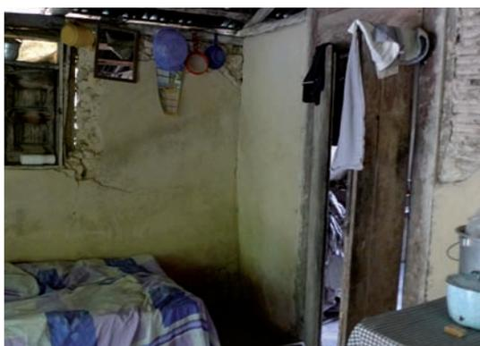
Endommagement partiel, lors du séisme de 2010, d'une paroi extérieure en maçonnerie de pierre et d'une cloison intérieure en clissage
