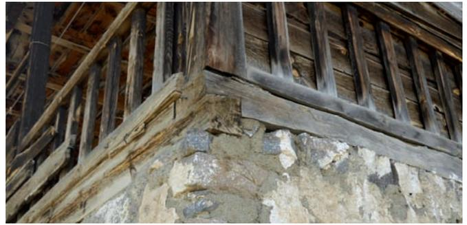
charpente / assemblage à mi-bois avec coupe en biais permettant un meilleur liaison des poutres de chaînage
