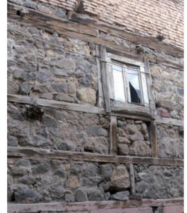
subdivision de la maçonnerie sous les ouvertures par des éléments verticaux en bois entre les chaînages
