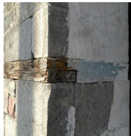
joint de prolongation des poutres de chaînage
