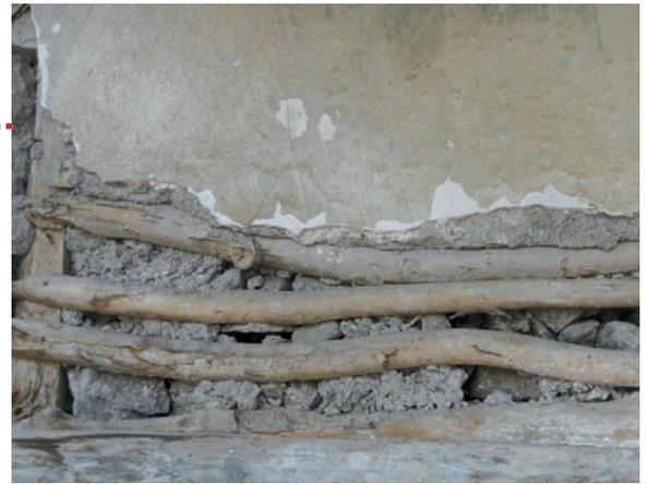
Éléments de cloison avec structure secondaire en bois et remplissage
