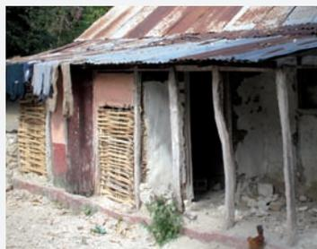
Fig.42: a) effondrement du remplissage en maçonnerie ; b) décollement de l'enduit et réutilisation des panneaux (gauche) (crédits: E.Cauderay)
