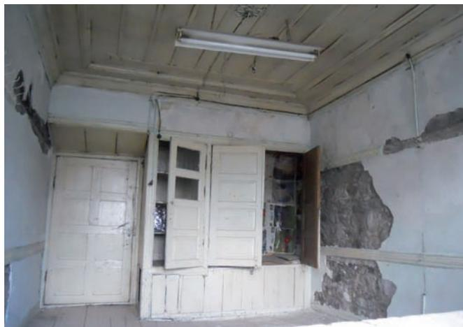
angles / maçonnerie en pierres de taille ; joint en biais connectant des poutres perpendiculaires du chaînage extérieur ; traverses reliant les poutres horizontales
