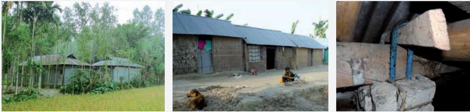
Fig.45: a) habitations en zone protégée; b) habitations sur la digue ; c) ancrage de la structure de toiture avec un assemblage permettant un démontage rapide (p.e. avec un coup de marteau)
