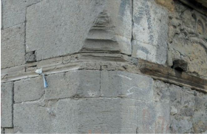
angles / maçonnerie appareillé en angle biseauté avec élément en biais de connexion entre chaînages extérieurs perpendiculaires (rez-de-chaussée, façades sur rue)
