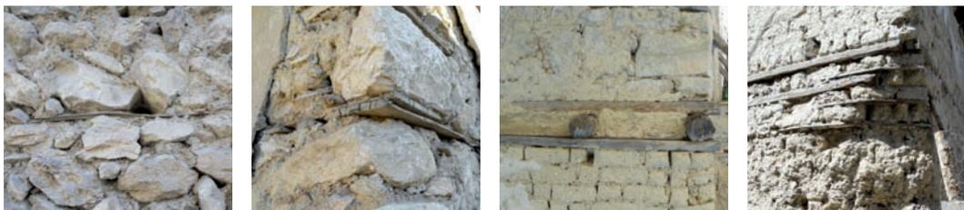
Fig.118: Types d'insertions horizontales (Safranbolu, Turquie): a) en fines lames en bois, b) en planches traversantes, c) en doubles poutres tout le long du mur ou (d) comme renforcement ponctuel
