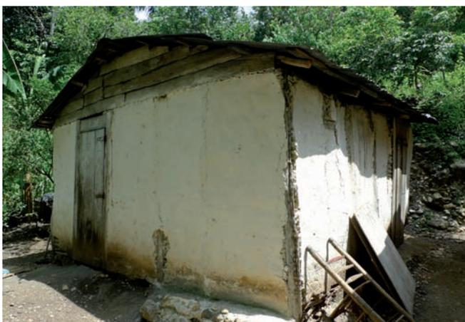
Structure avec poteaux en bois et remplissage en clissage :
