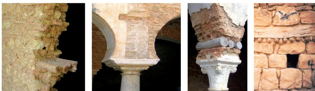
Fig.122: Insertions en rondins (Algérie) : a) traversant l'épaisseur du mur ; b) à la base des arcs et (c) en tête de colonne ; d) variante de la région d'Arès (sources : a) ABDESSEMED FOUFA, BENOVAR, 2008 ; b et c) FOUFA, 2007 ; d) MEDA CORPUS, 2011)
