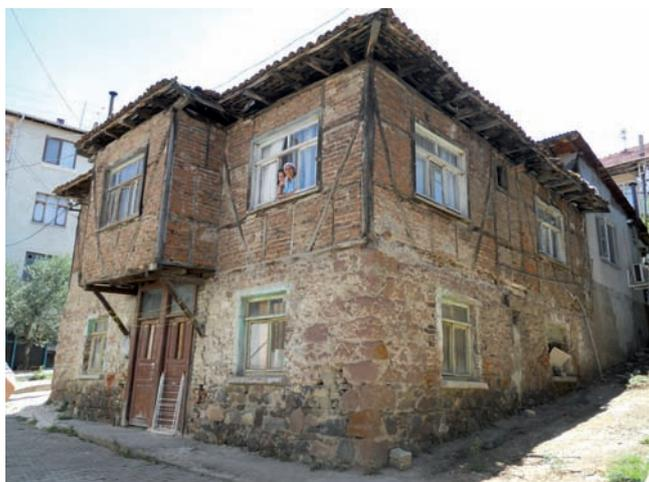
Gölcük : structure en maçonnerie et *himış* (briques en terre cuite); elle n'a pas subi des dégâts lors du séisme de Kocaeli de 1999
