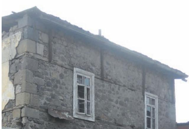
renforcements / parfois la toiture est ancrée aux chaînages inférieurs par des éléments verticaux en bois
