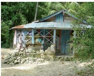
Exemple : dans certaines habitations des zones rurales d'Haïti, la clôture de la galerie est réalisée avec des planches en bois disposées en croix entre les poteaux, qui reposent sur un soubassement en maçonnerie de pierre. Ces éléments agissent en tant que contreventement, assurant une certaine cohérence structurelle et évitant un effondrement de la superstructure, même en cas d'écroulement du soubassement (Fig. 137a, analyse de terrain 2012).
