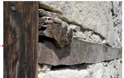
connexion traverse-poutre de chaînage
