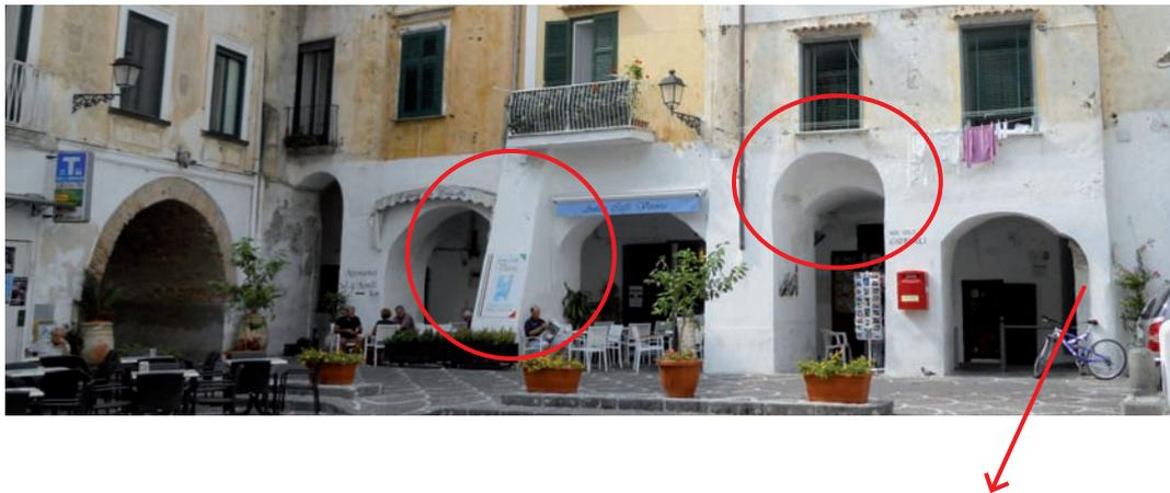
Fig.113: Renforcements postérieurs à la construction d'origine (Atrani, Italie) : a) contrefort ponctuel et doublement de la façade avec (b) juxtaposition de piliers à la structure préexistante encore visible
