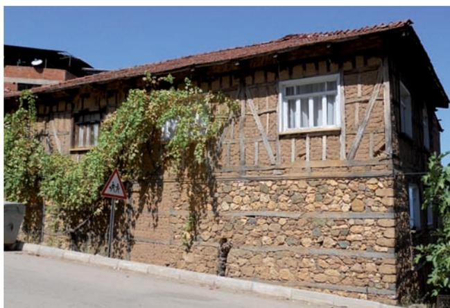
Narlıca : structure mixte avec rez-de-chaussée en maçonnerie en pierre avec *hatillar* en bois et étage en *himış* (briques en terre crue)
