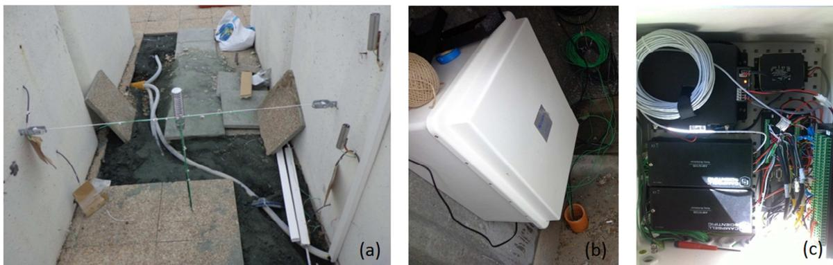
Figure 3-8 : Acheminement<sup>(a)</sup> souterrain des câbles de capteurs vers la centrale d'acquisition<sup>(c)</sup> placée dans un boîtier étanche<sup>(b)</sup> à l'intérieur d'un bloc du bâtiment central
