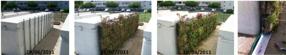
**Figure 3-5 - Mise en place d'un système de façade végétalisée composée de caissons de sphaigne attachés à une grille métallique**
