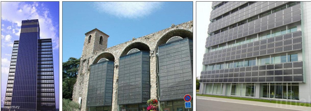
**Figure 1.20 – De gauche à droite, photographies d'une façade PV classique pour l'utilisation de grandes surfaces à empreinte au sol nulle, d'une façade double peau pour la rénovation énergétique de bâtiments anciens, et de la façade PV biface du bâtiment Sanyo (reproductions issues respectivement de [98], [99] et [93]).**
