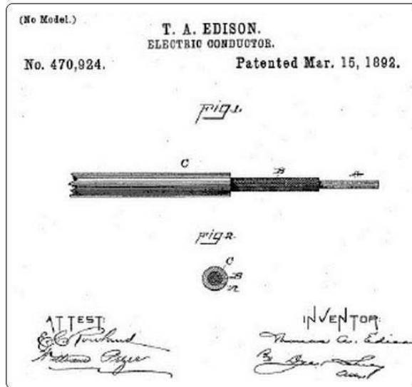
**Figure I.1** – Le premier câble électrique inventé par Thomas EDISON, A) Conducteur, B) Tresse , C) Isolant en caoutchouc [1].
