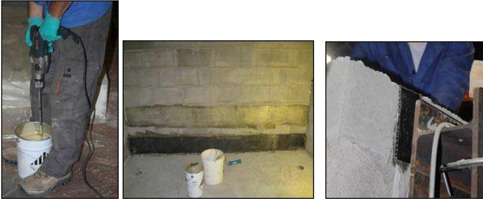
Fig. 2.22.a) Mélange de résine ; b) Pose d'une bande TFC horizontale ; c) Recouvrement de 20cm à l'arrière du mur principal pour ancrage de la bande
