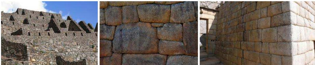
Fig. 4.118. Maçonnerie en pierres des joints secs à Pérou.
