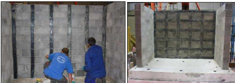
Fig. 2.24. Renforcement horizontal et vertical du quatrième mur.
